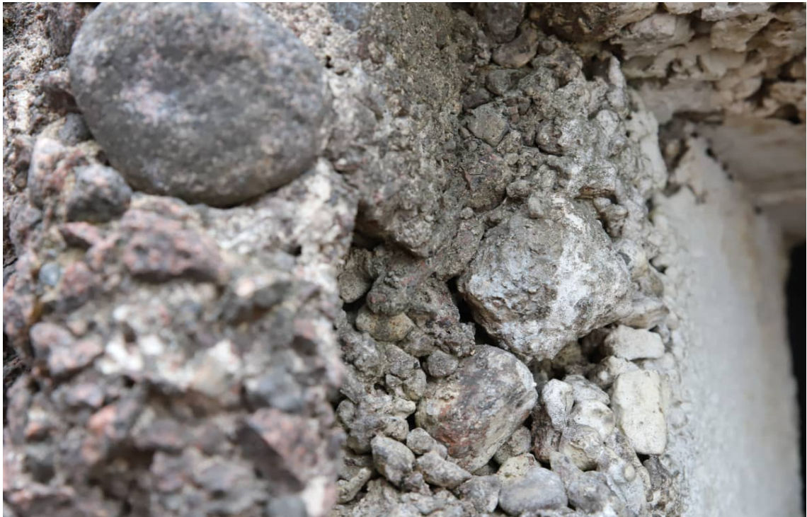
Kuva 5. Salpalinjalla Miehikkälässä sijaitsevan korsiin betonia. [16.]
