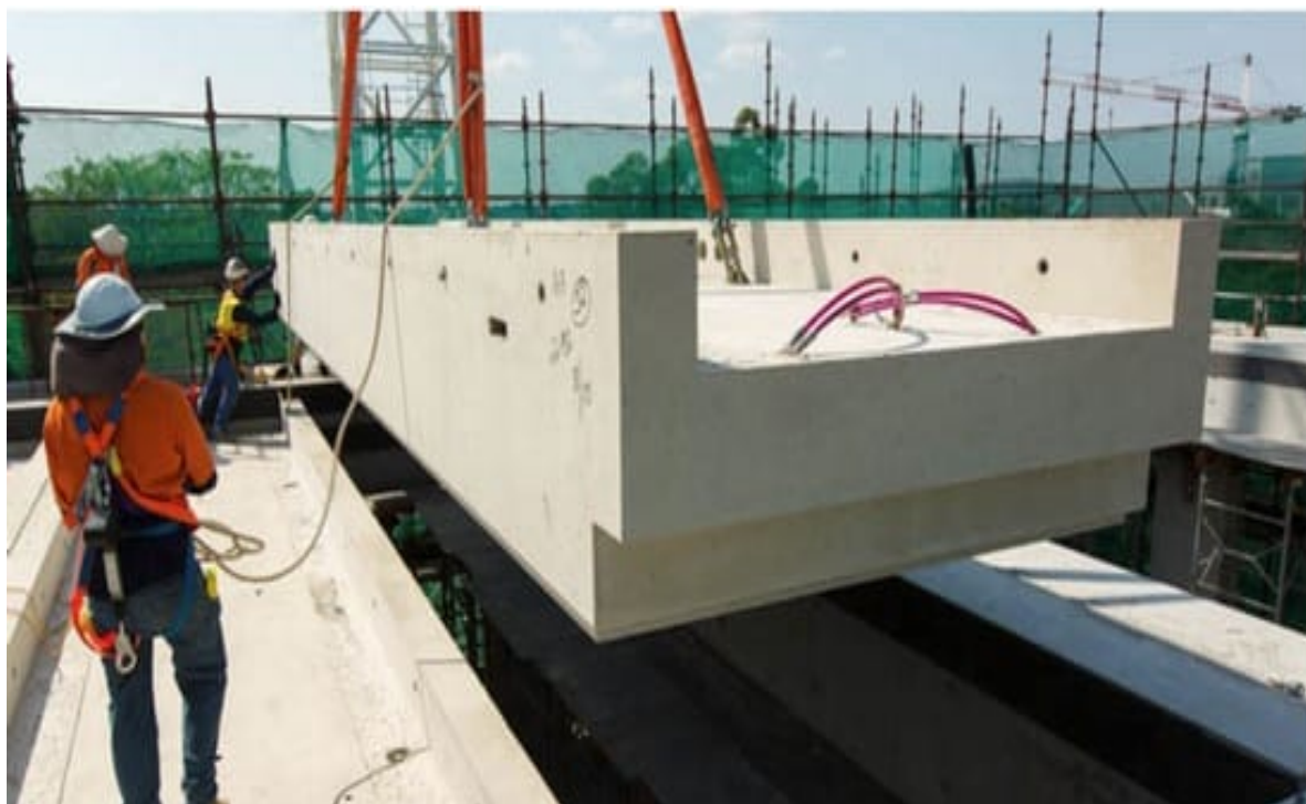
Kuva 17. Geopolymeeribetonielementin asennus maailman ensimmäiseen rakennukseen, jossa käytetään geopolymeeribetonia. [56.]
