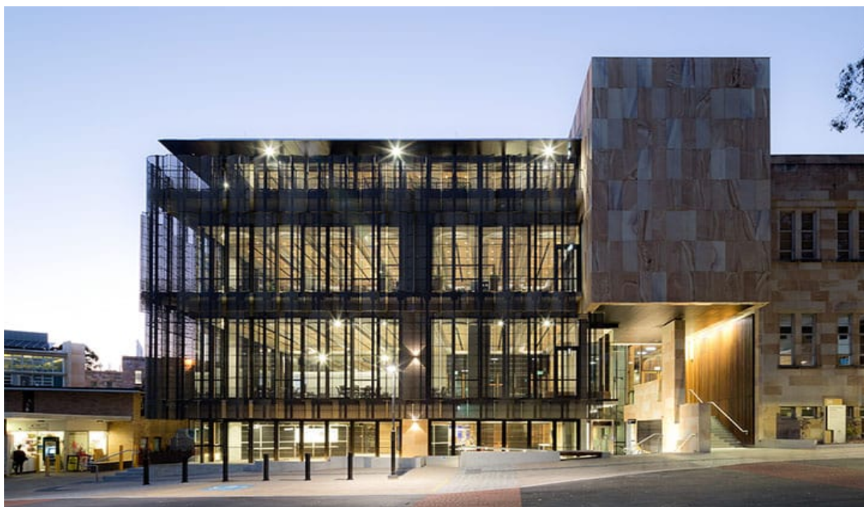
Kuva 16. Australian Queenslandin yliopiston rakennus on maailman ensimmäinen rakennus, jossa on käytetty geopolymeeribetonia. [56.]
