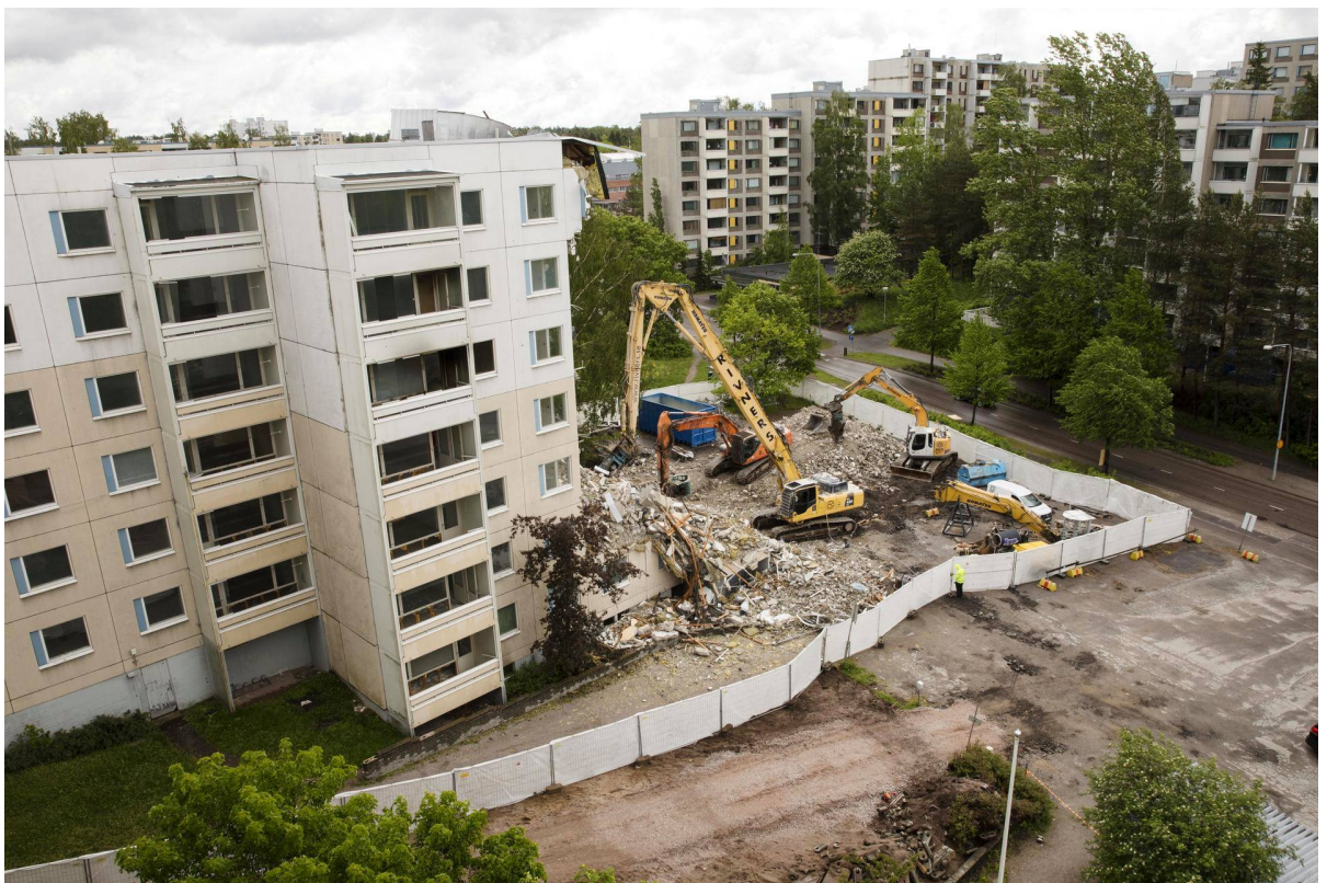
Kuva 7. 1970-luvun betonilähiön purkutyöt Espoon Suvelassa ovat täydessä vauhdissa kesällä 2019. [19.]
