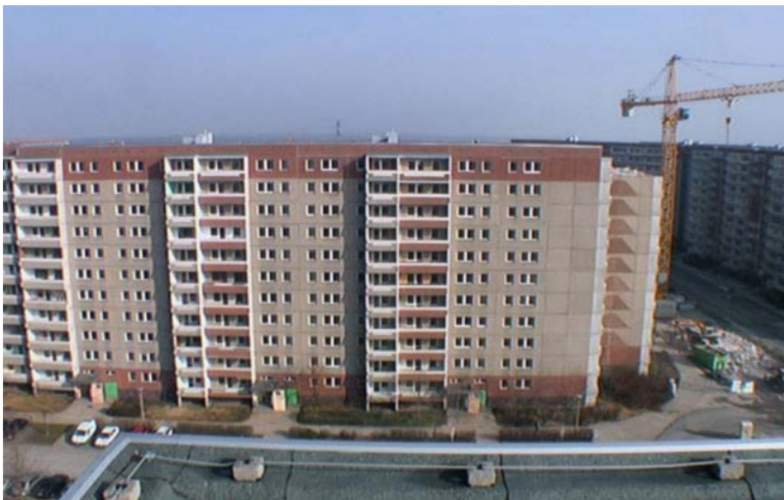
Kuva 21. 11-kerroksiset lamellitalot ennen muutosta. [71.]
