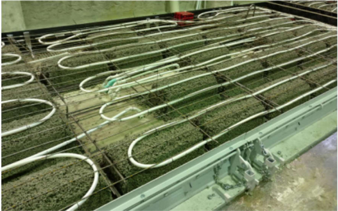
Kuva 13. Lattialämmitysputkien asennus superlaattaan (22)
