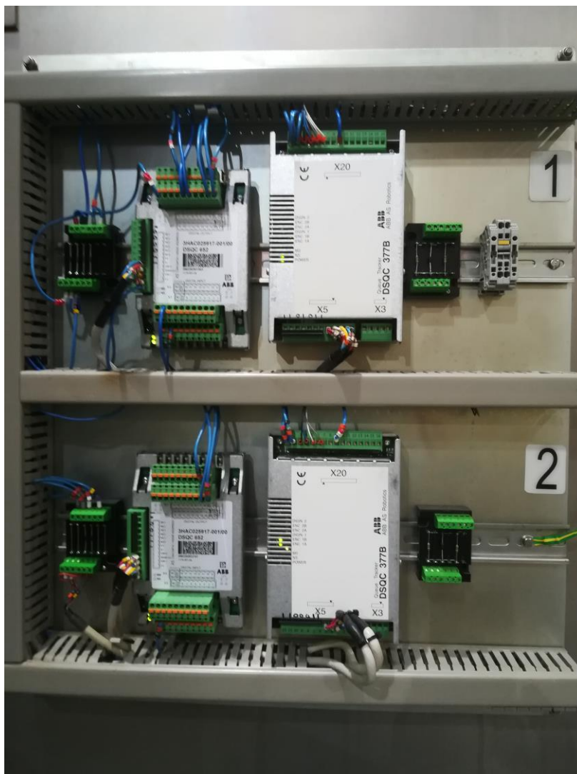
Kuva 3. ABB IRB 360 I/O- (vas.) ja radanseurantakortit keskuksen ovenssa
