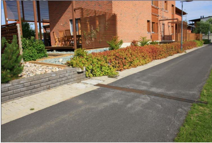
KUVIO 10. Tonttien ylimääräisen pintaveden ohjaus läheiselle viheralueelle (Kuva: Matleena Hallikainen, 18.7.2010).
