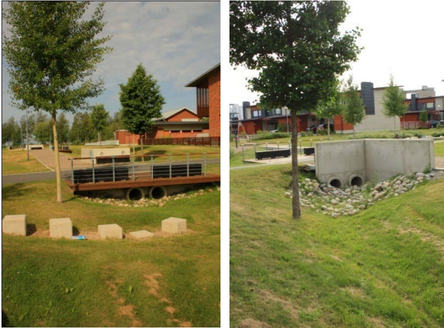
KUVIO 11. Alueen läpi kulkevan uoman sadeveden keräys- ja viivytyspainanne (kuva vasemmalla) ja ylivuotoputki sillan toiselle puolelle (oikealla oleva kuva) (Kuvat: Matleena Hallikainen, 18.7.2010).
