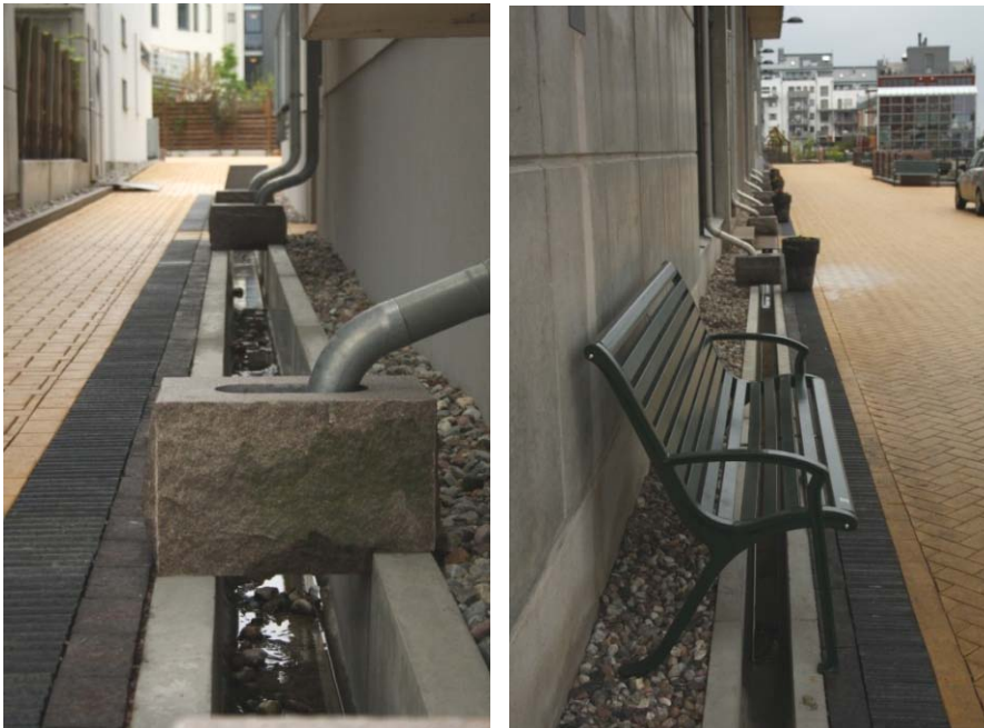
KUVIO 17. Kattoveden keräysjärjestelmä (Kuvat: Matleena Hallikainen, 16.5.2010).
