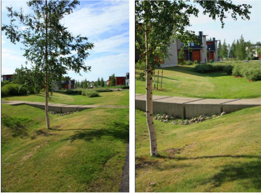
KUVIO 13. Viheralueen ylittävä siltarakenne Toppilansaaressa, jossa on raot veden virtauksen mahdollistamiseksi (Kuvat: Matleena Hallikainen, 18.7.2010).
