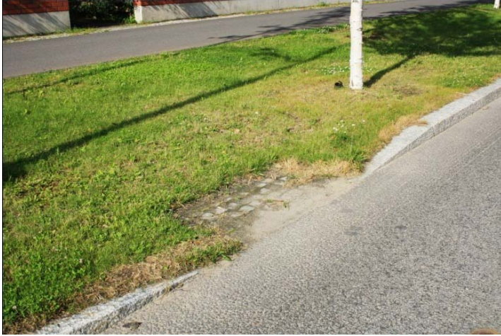
KUVIO 14. Sadeveden imeytysaukot Pitkänmöljängtiellä (Kuva: Matleena Hallikainen, 18.7.2010).
