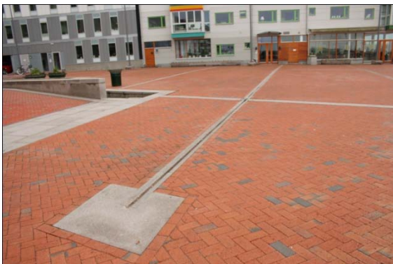
KUVIO 20. Aukion pintavaluntaa keräävä ja ohjaileva kouru (Kuva: Matleena Hallikainen, 16.5.2010).
