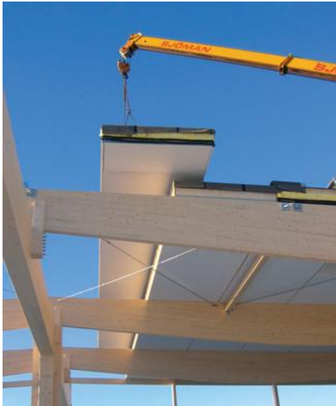
Kuva 4. Kattoelementin asennus Rautia Klaukkalan rakennustyömaalla. (2)
