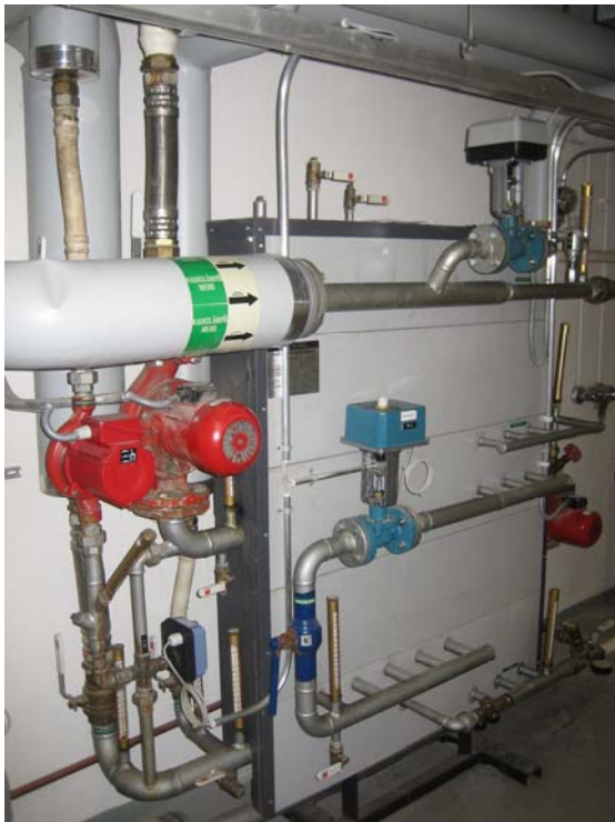
Kuva 3. Lämmönjakokeskus.
