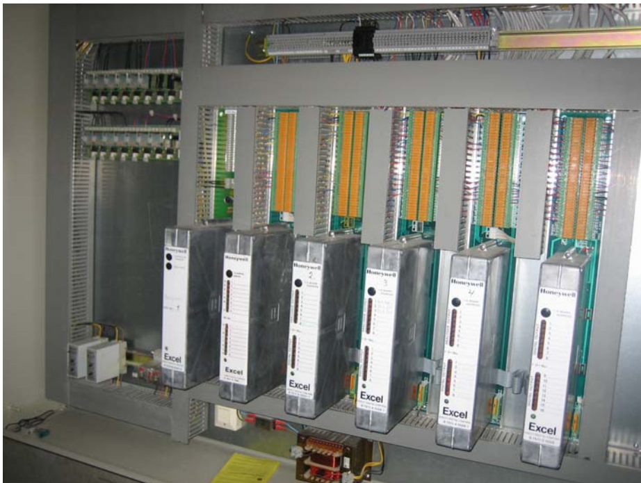
Kuva 2. Alakeskus AK-1:en vanhat säätölaitteet.
