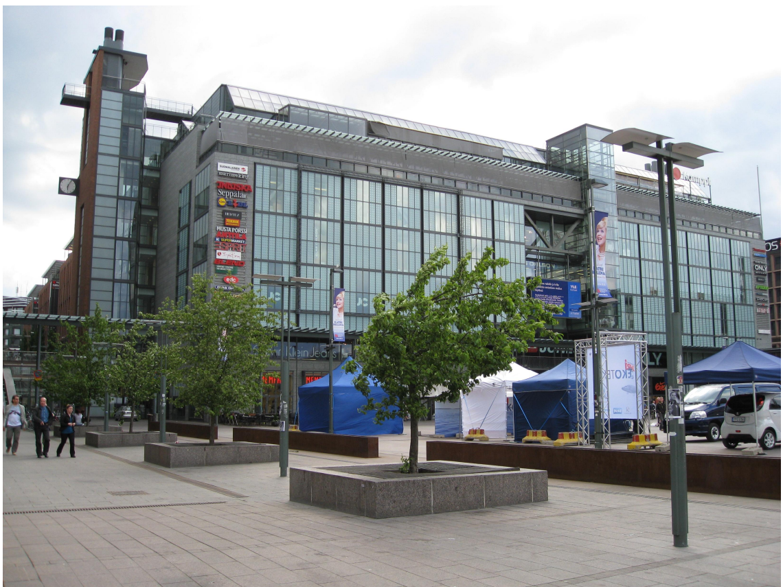
Kuva 1: Kauppakeskus Kamppi Narinkkatorin suunnasta kuvattuna. Vasemmalla taustalla näkyvät Kampin keskuksen kuuluvat toimistotornit.
