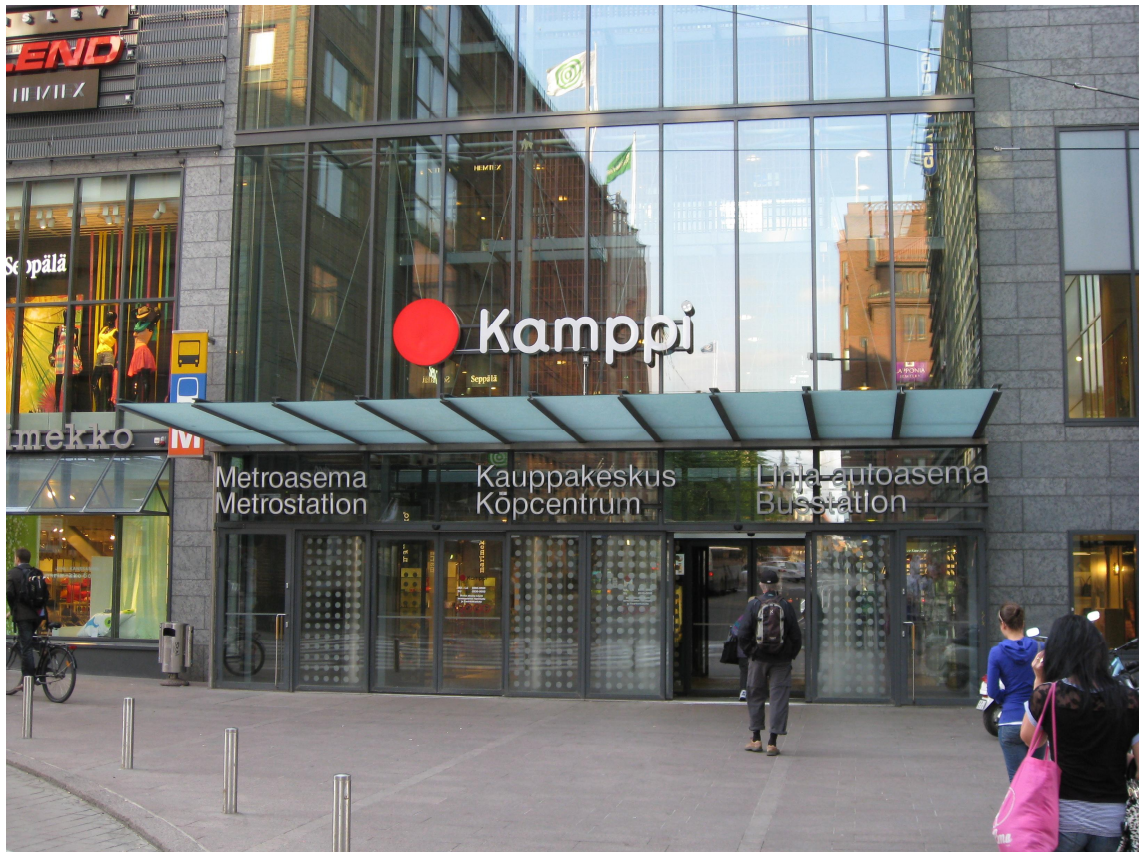
Kuva 9: Kauppakeskuksen Annankadun sisäänkäynti.
