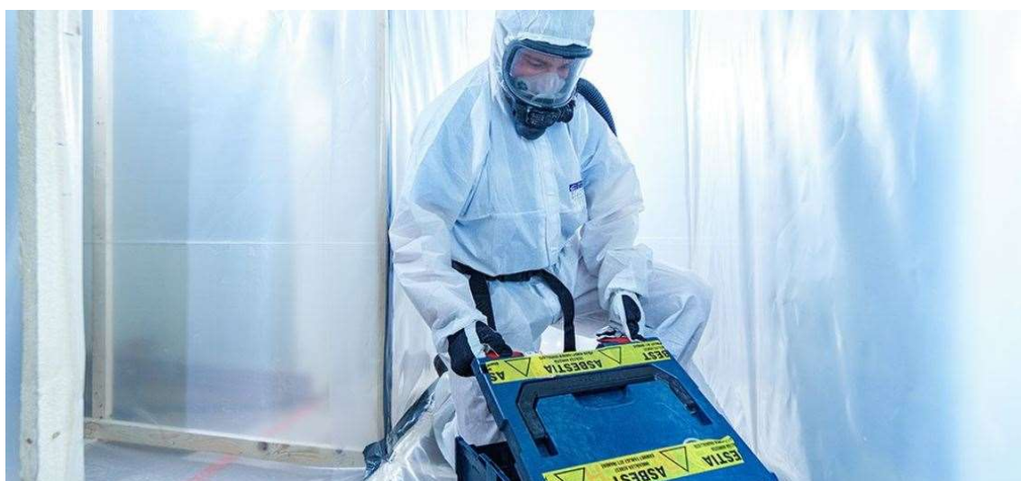
Kuva 11. Asbestityö: henkilösuojaimet ja osastoiva suojaseinä [36].
