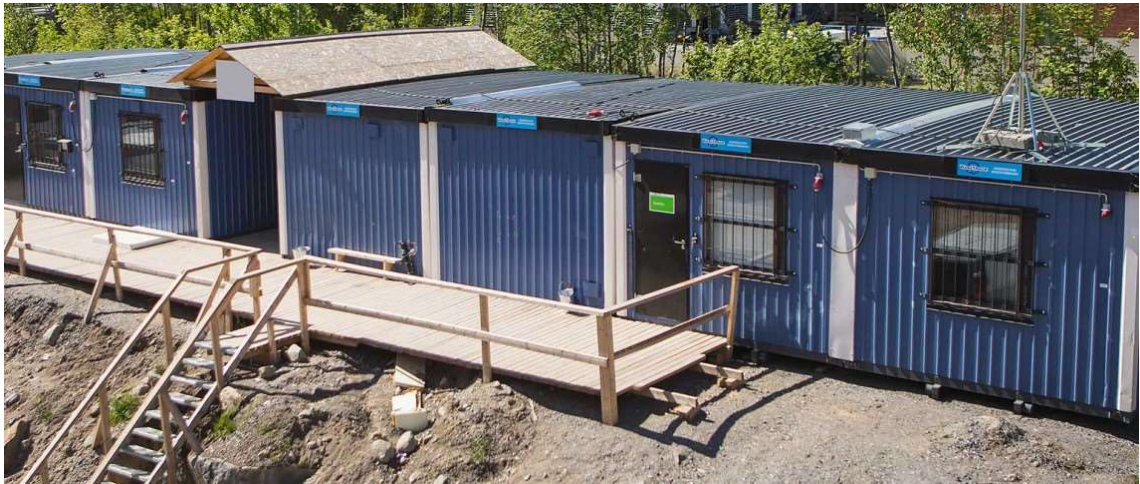
Kuva 8. Esimerkki työmaakonteista mm. toimisto- ja sosiaalitulojen järjestämiseen [25].
