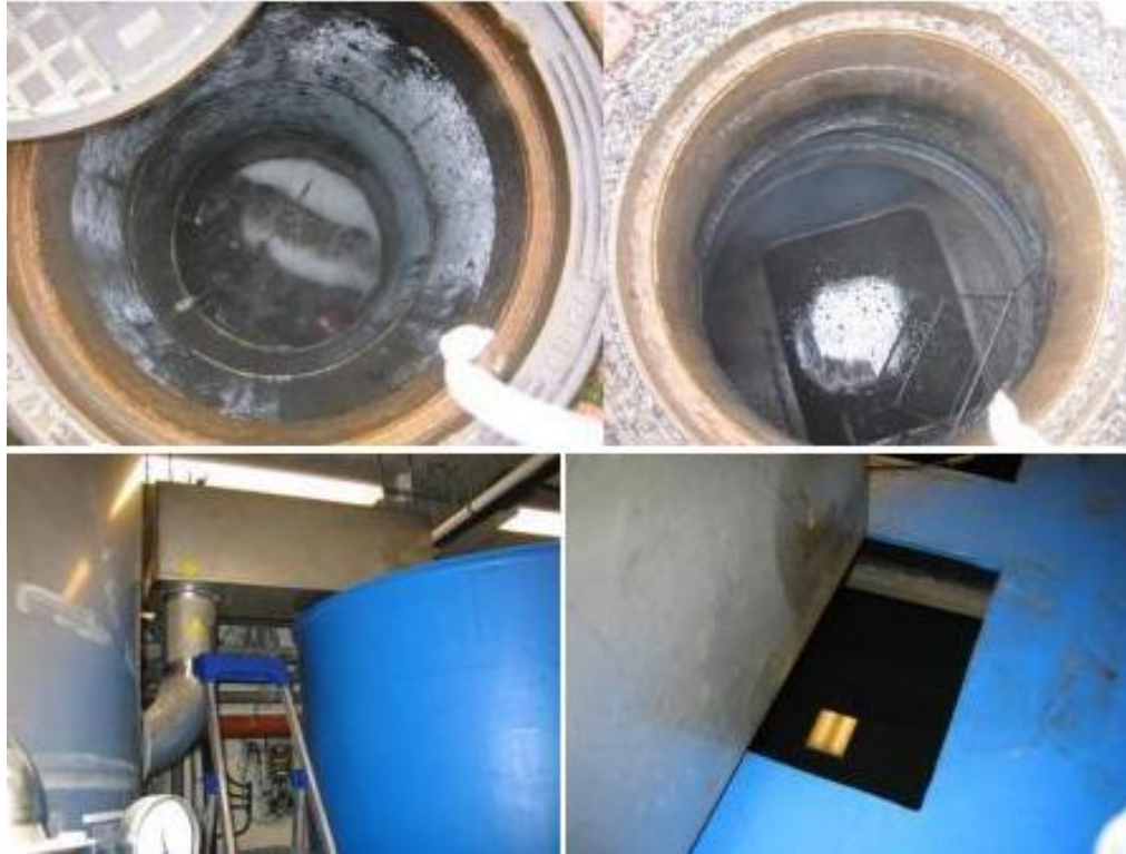
KUVIO 12. Näytteenottopisteet. vasen ylänurkka puhdistusprosessi, oikea ylänurkka hiekanerotus, alhaalla puhtasvesisäiliö
