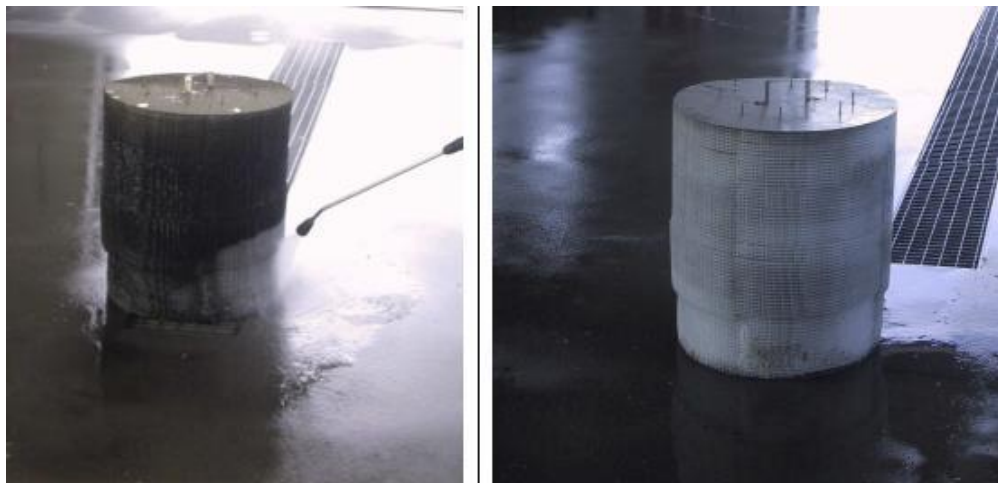
KUVIO 6. Luokan I öljynerottimen koalisattoriyksikkö (Wavin-Labko Oy 2005, 12)
