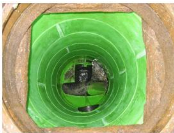
KUVIO 8. Kaivon panelointi (Putkistojen kaivamattomat saneerausmenetelmät 2011)
