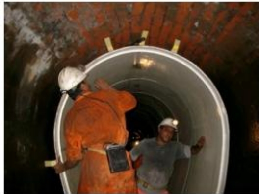
KUVIO 7. Elementtivuorausta suuressa viemärissä (Putkistojen kaivamattomat saneerausmenetelmät 2011.)
