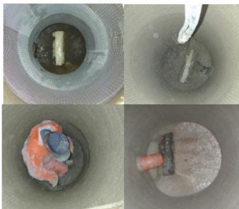
KUVIO 10. Sementtivuorauksen toteutus saneerauskaivossa (Putkistojen kaivamattomat saneerausmenetelmät 2011)
