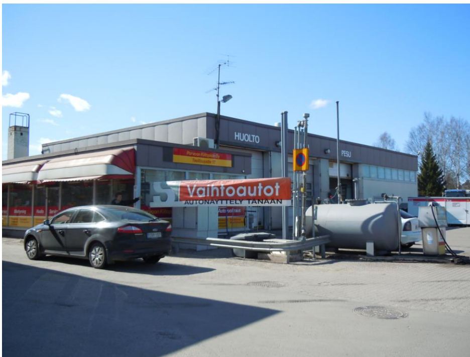
Bild 3. Uppsättning av reklamlakan vid Kiitopiste Oy
