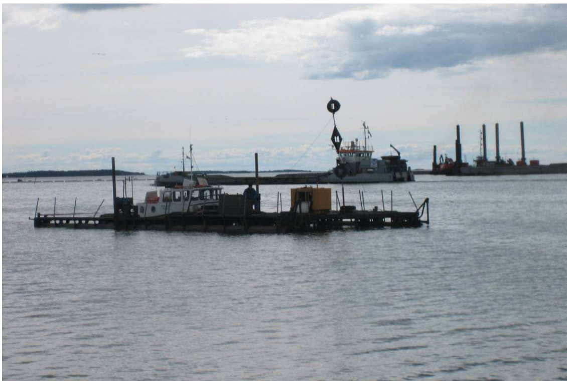
Kuva 5. Etualalla olevan haran takana proomu on matkalla läjitysalueelle. Taustalla on porauslautta ja ruoppaaja työssä.
