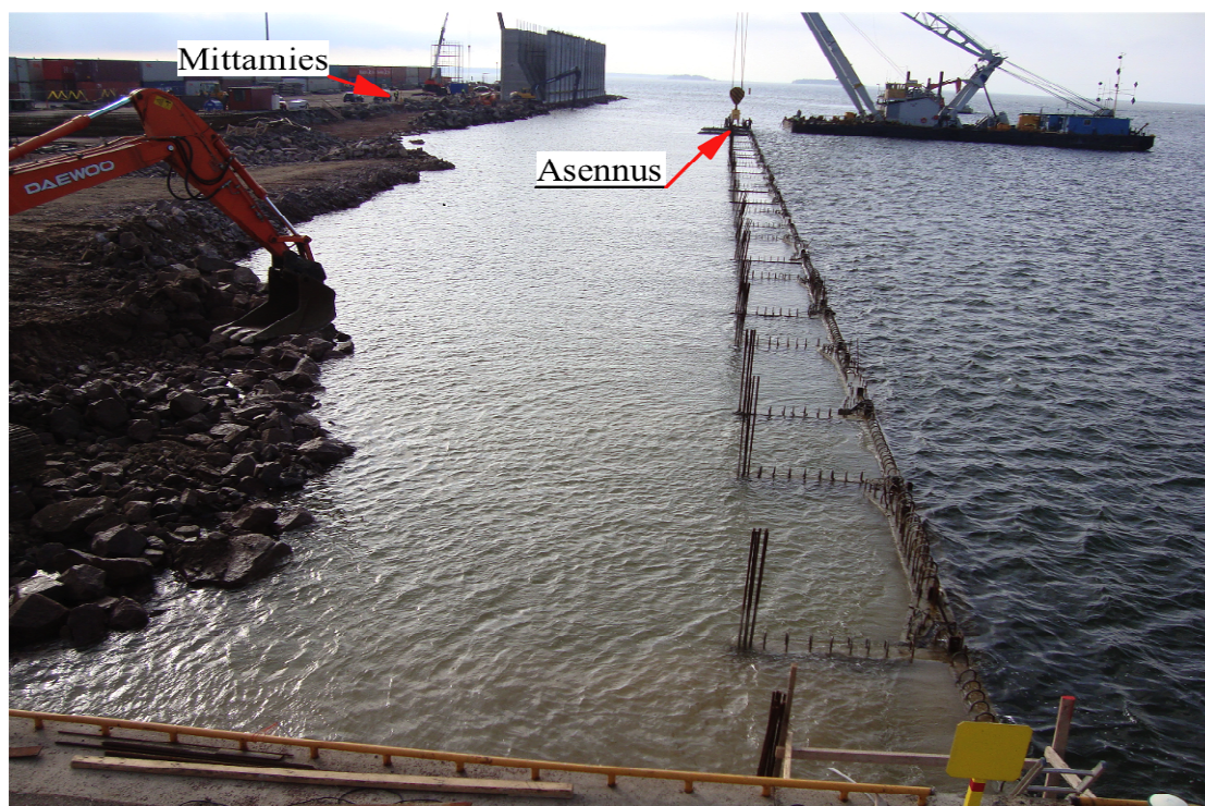
Kuva 20. Sivusta-asennusmittaus käynnissä.
