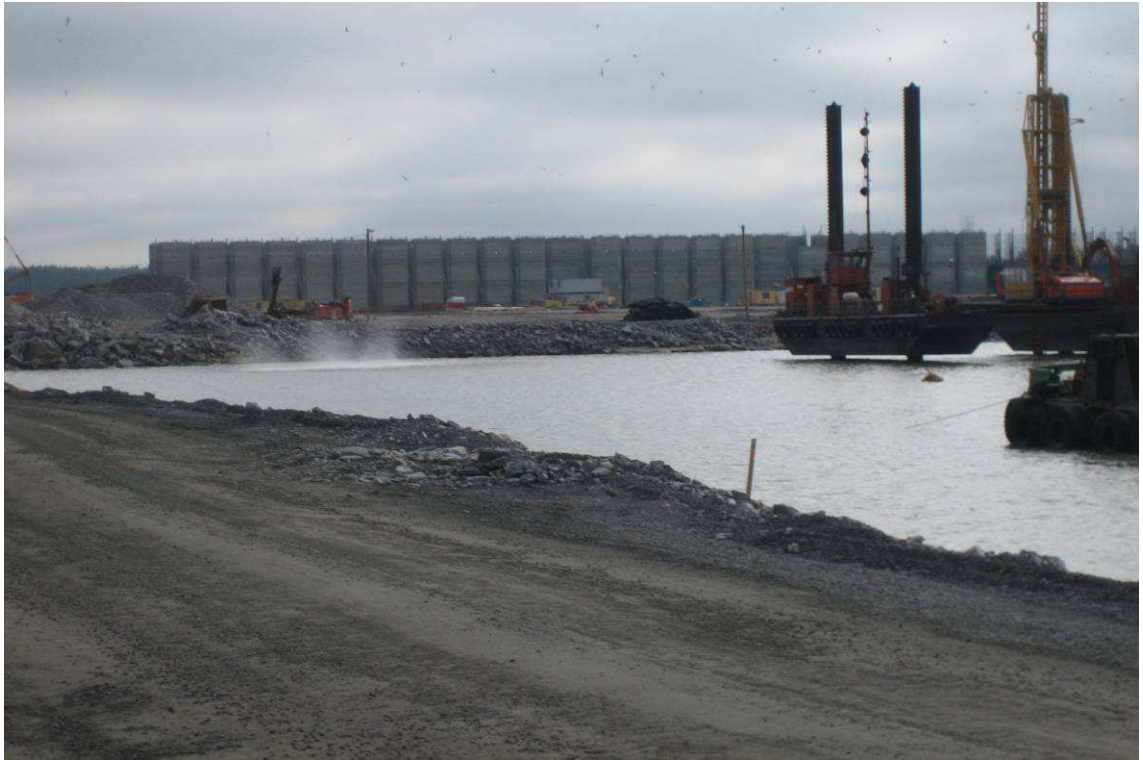
Kuva 4. Porauslautta on tunkattu irti vedestä räjäytyksen ajaksi. Taustalla on valmis elementtirivi odottamassa asennusta.
