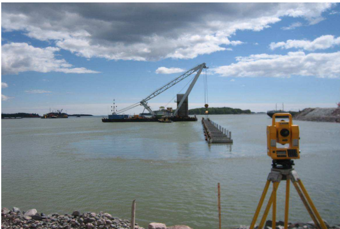
Kuva 11. Elementtirivistöä meressä. Asennus mitattiin takymetrillä.
