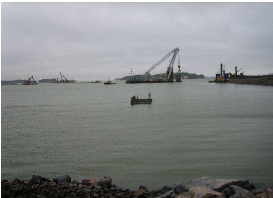
Kuva 2. Ensimmäinen laiturielementti on mitattu paikoilleen Vuosaaren satamassa ja seuraava on nosturilautan koukussa tulossa asennettavaksi. Taustalla Terramaren laivastoa merellä.
