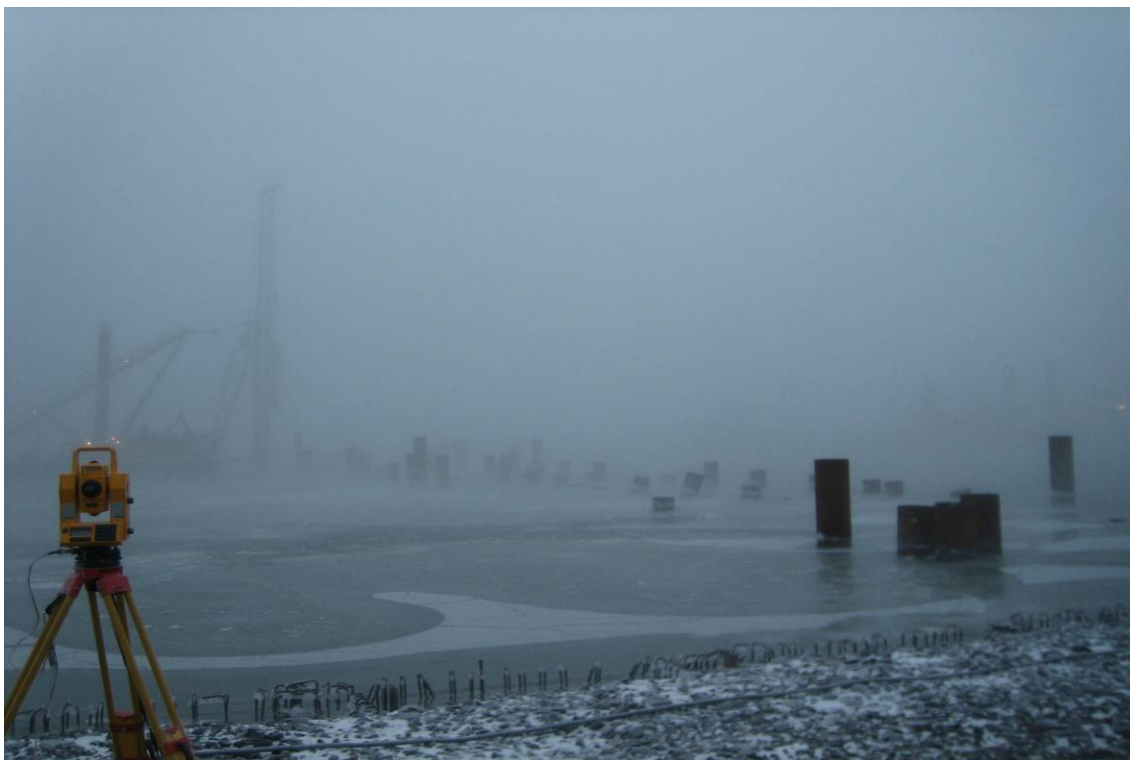
Kuva 31. Pystypaalun asennusmittaus.
