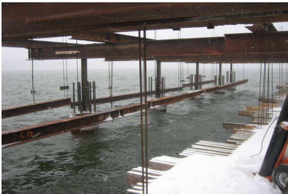
Kuva 13. Riipputuenta pistolaiturilla. Keskimmäisellä palkilla on pohja valmiina. Reunapalkin I-palkit odottavat mittamiestä korkeuden säätämistä varten.
