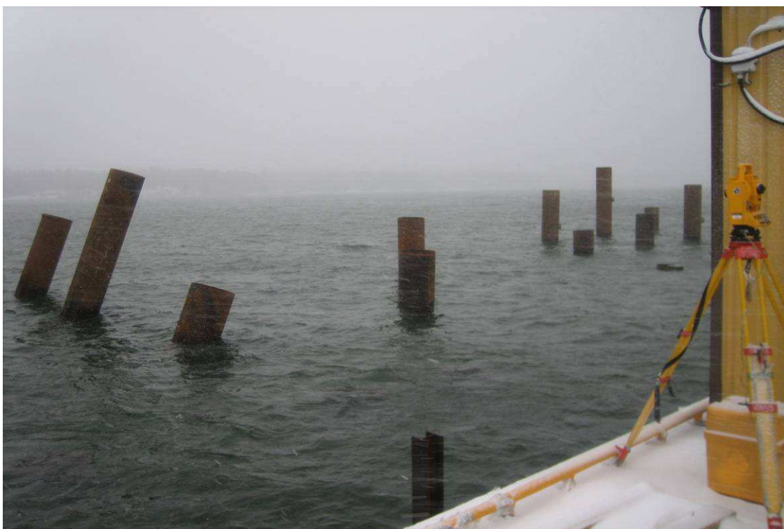
Kuva 30. Mittamies laski putkipaalujen koordinaatit paperipiirustusten perusteella.
