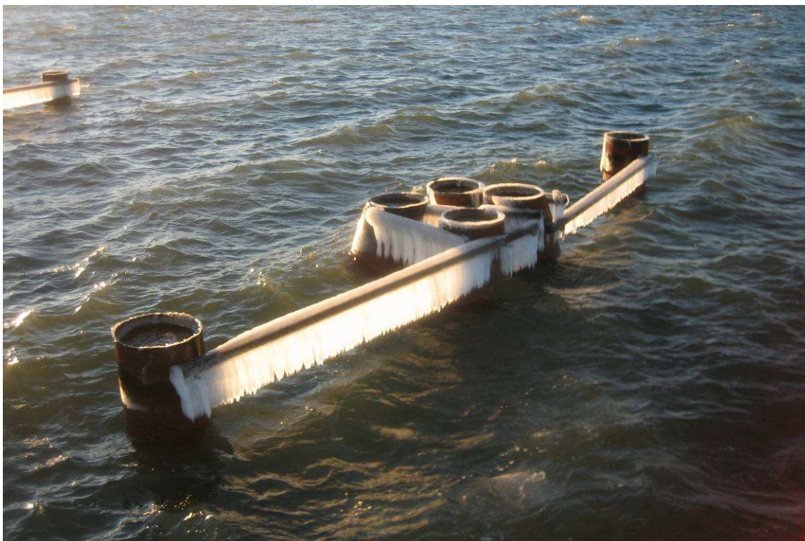
Kuva 34. Putkipaalujen lyönnin jälkeen ne katkaistiin mittamiehen antamien korkeusmerkkien perusteella ja tuettiin toisiinsa.
