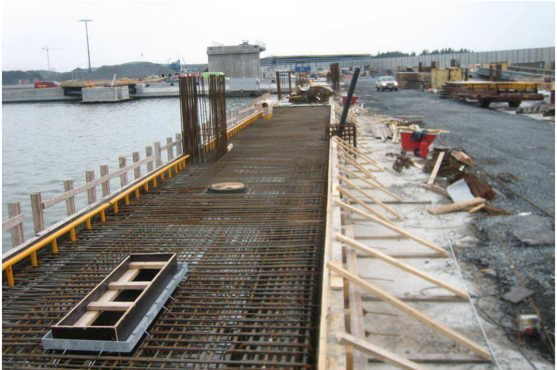
Kuva 28. Tunnelilaiturin kansilaatan jakso on valmis betonoitavaksi.
