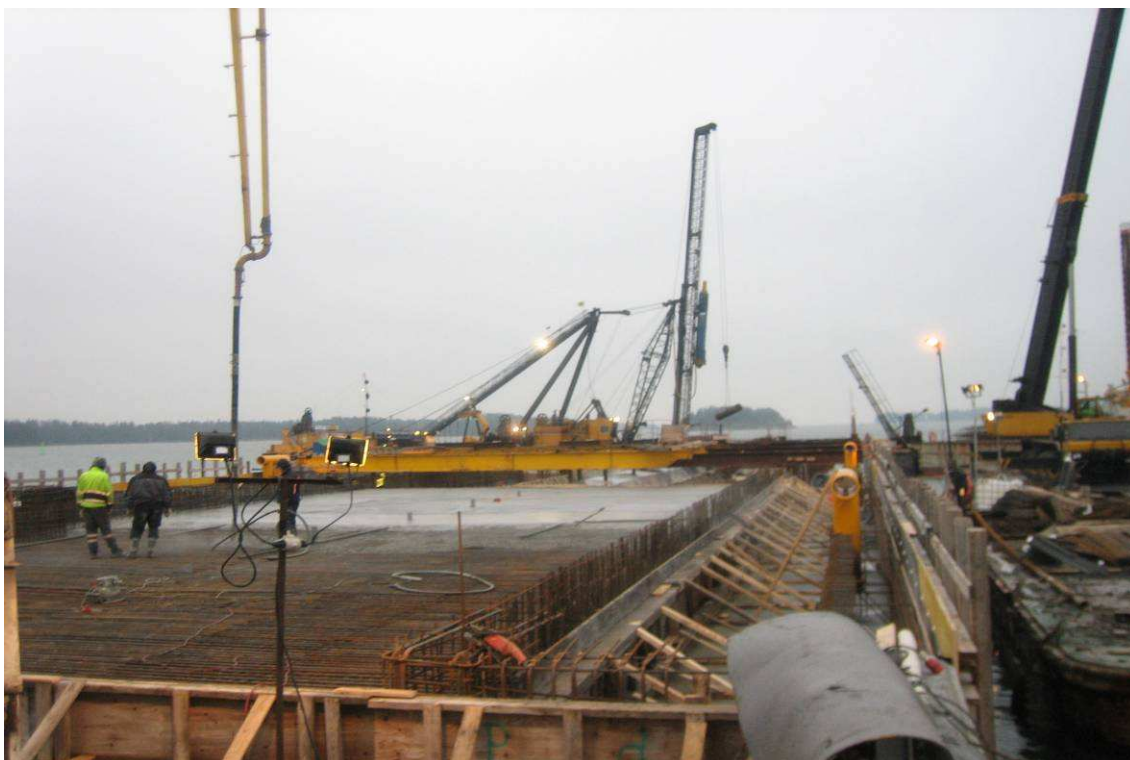
Kuva 14. Kuorilaattojen alue raudoitettiin ja betonoitiin pistolaiturin kansilaataksi.
