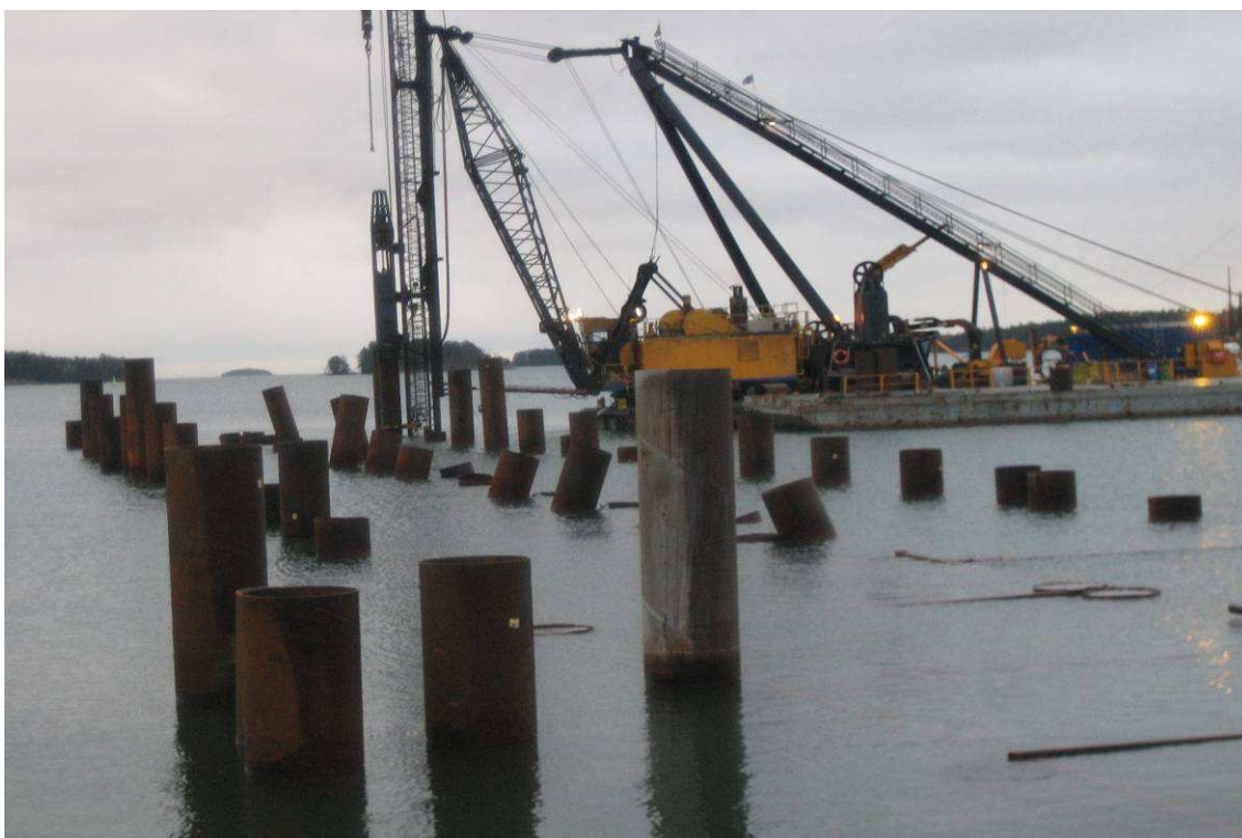
Kuva 29. Paalutuslautta Meri-Pekka suorittamassa pistolaiturin paalutusta.
