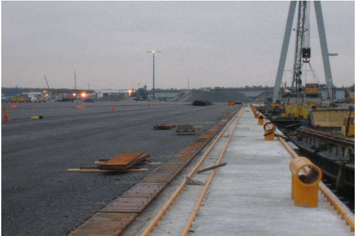
Kuva 27. Tunnelilaiturin kansi. Kuvassa pollarin ulkopuolella on keltainen reunateräs ja sisäpuolella nosturin keltaiset virranottokaapeliin ohjainteräkset. Nosturikiskon aluslevy on aluspulttien mutterien varassa. Aluslevyjen korkeus on säädetty millimetritarkkuudella. Kiskon asennuksen jälkeen kiskopalkin ja aluslevyn väliin tehtiin jälkivalu.
