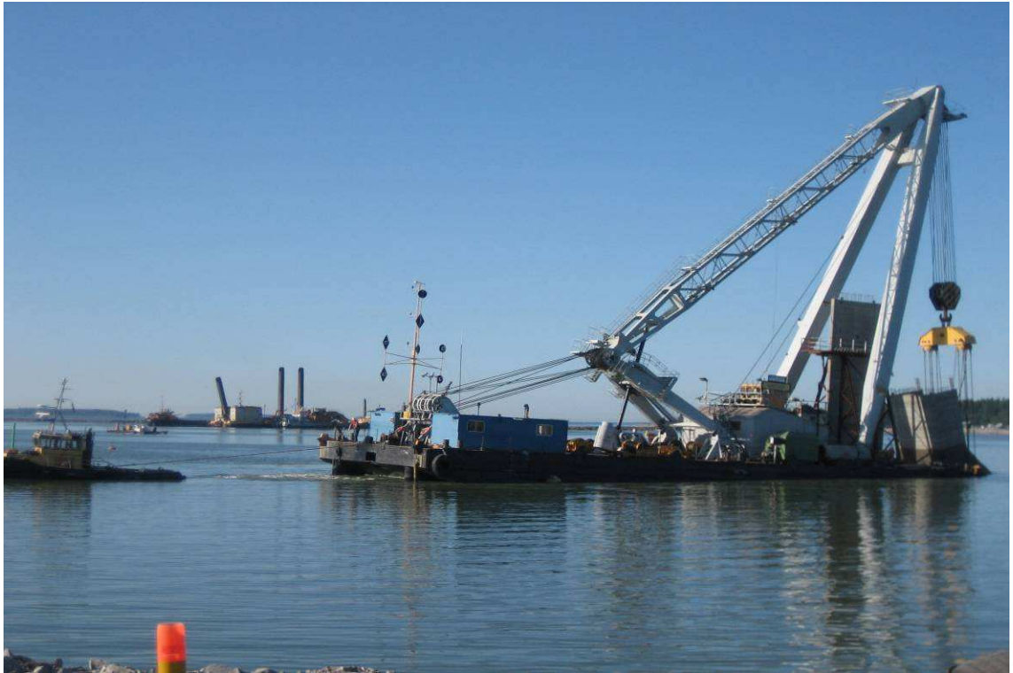
Kuva 21. K-elementti riippuu vinossa. Kannella mukana myös S-elementti.
