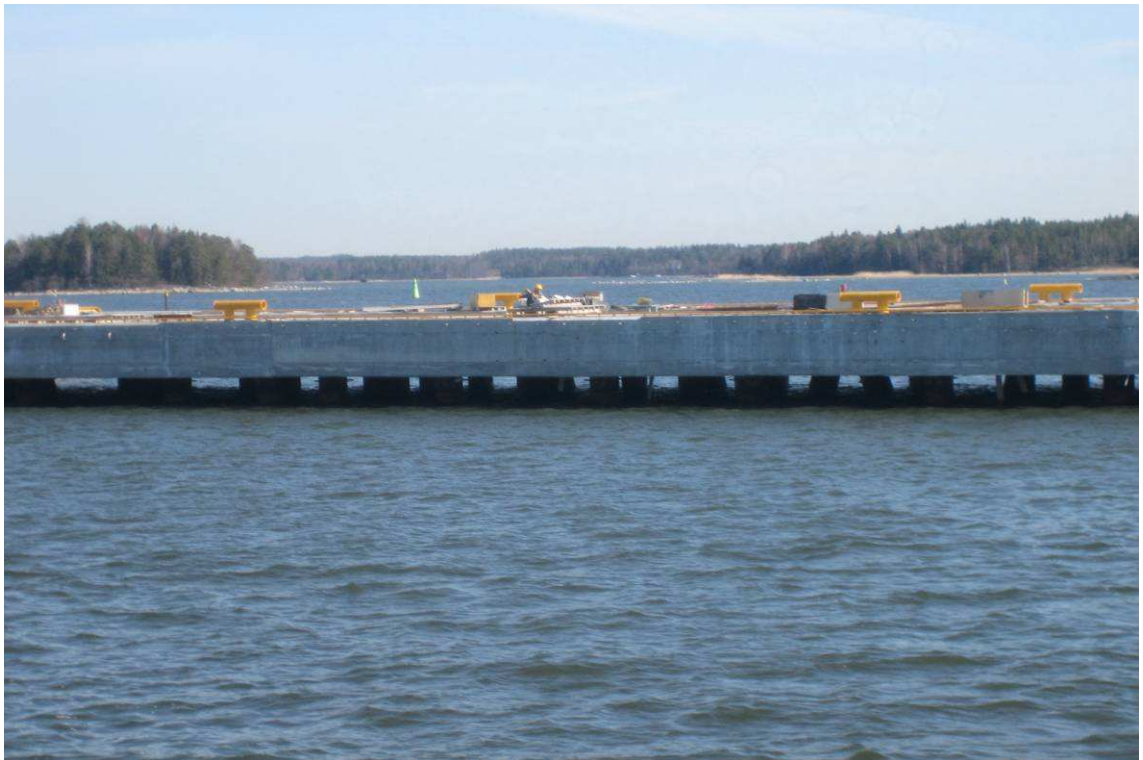
Kuva 12. Pistolaituri perustetaan putkipaalujen varaan.
