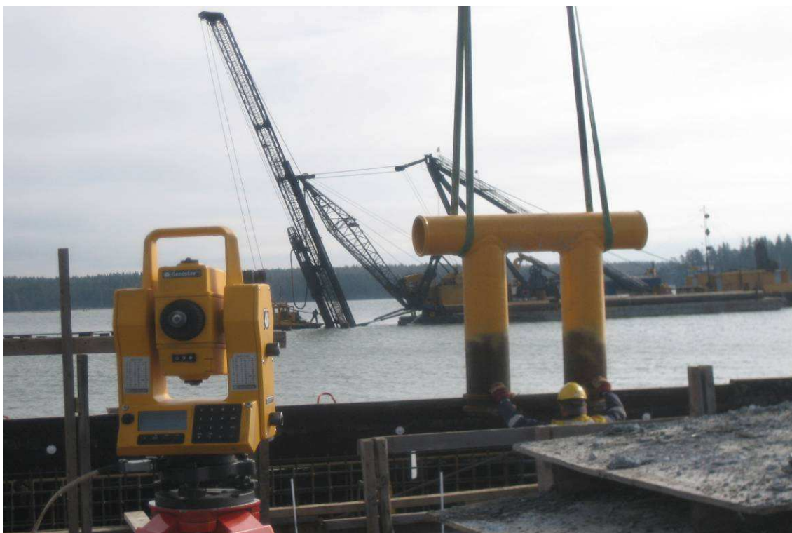
Kuva 26. Laituripollarin asennusmittaus tehtiin tässä vinopaalun mittauksen yhteydessä.
