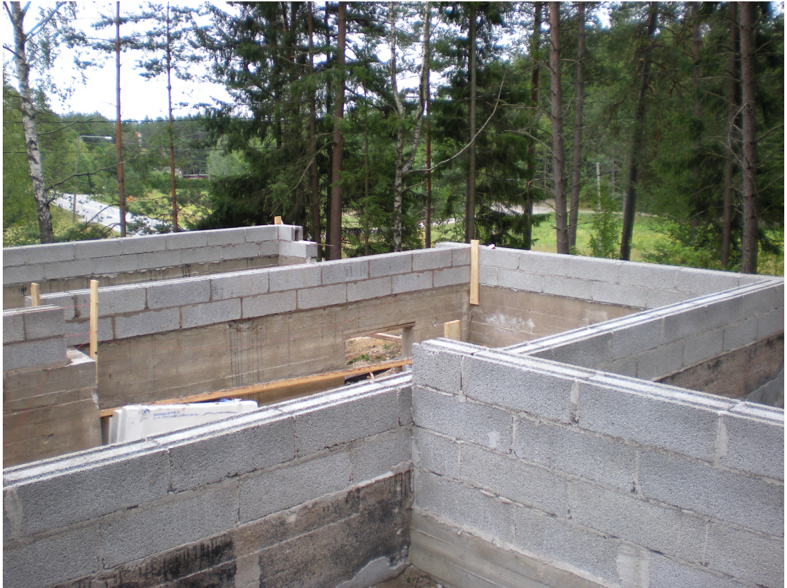
Kuva 3: Näkymä rakennuspaikalta länteen päin elokuussa 2008.
