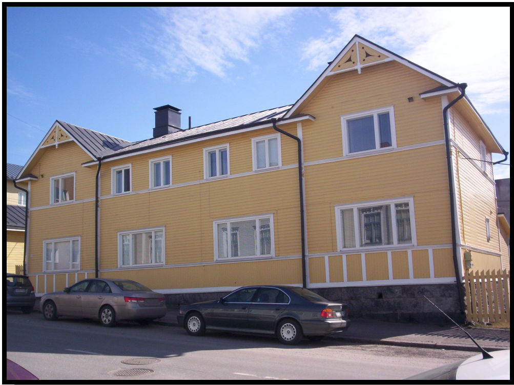
Kuva 1. B-talon julkisivu Kalastajankadulle.
