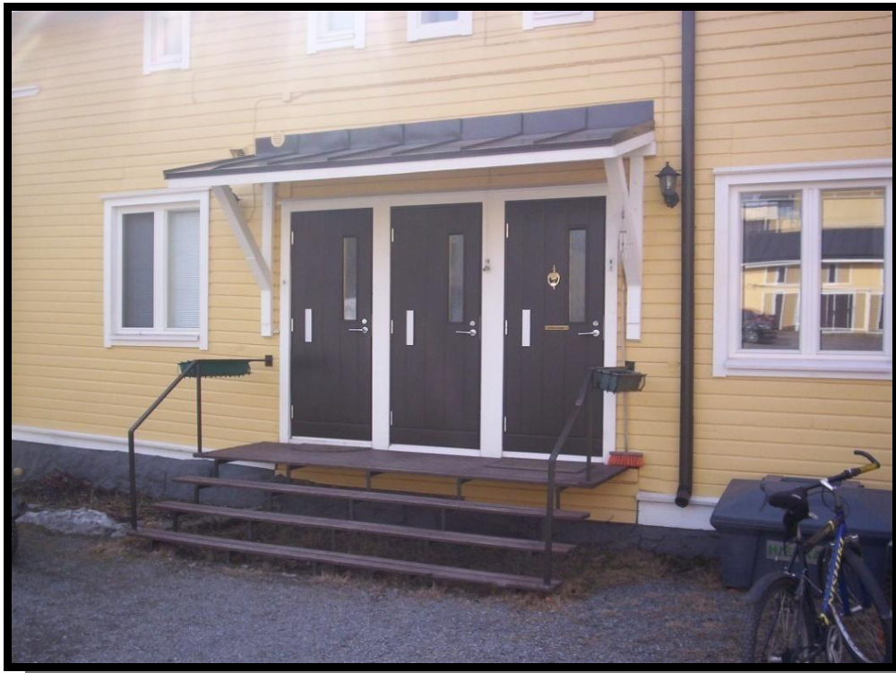
Kuva 6. Uusittuja ulko-ovia ja ikkunoita.
