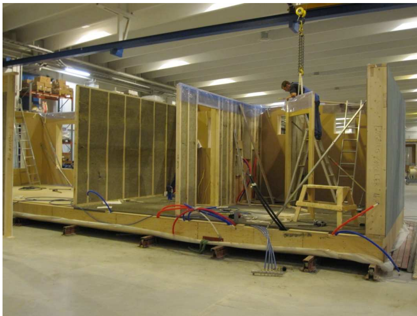
Bild 2. Bild av en modul i monteringskedet.
