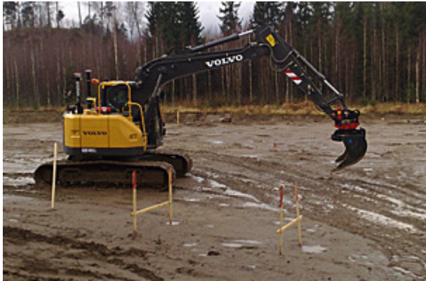
Kuva7. GPS ohjattu kaivukone.(Scanlaser Oy verkkosivut[viitattu 19.3.2009].)
