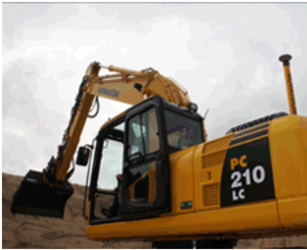
Kuva4. Kaivukone varustettuna yhdellä GPS- vastaanottimella. (Novatron Oy verkkosivut[viitattu 1.3.2009])
