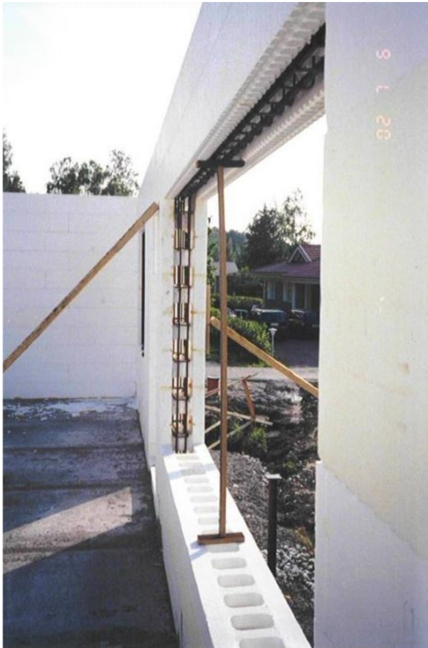
Kuva 15. Ikkunan ympärillä pilari- ja palkkirauditus. (Malander 2009 [23.1.2009]).
