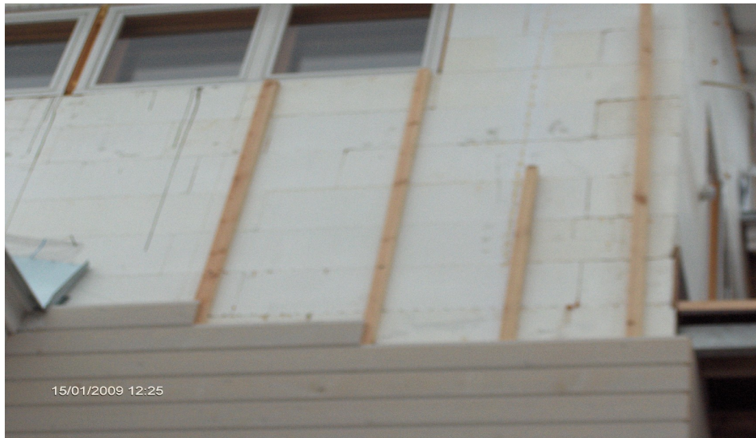
Kuva 12. Puuverhouksen kiinnitys EPS-valuharkon ulkopintaan
