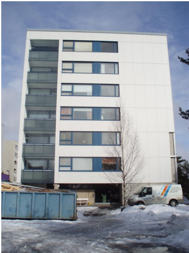
Kuva 5. Julkisivu lähes valmiina.
