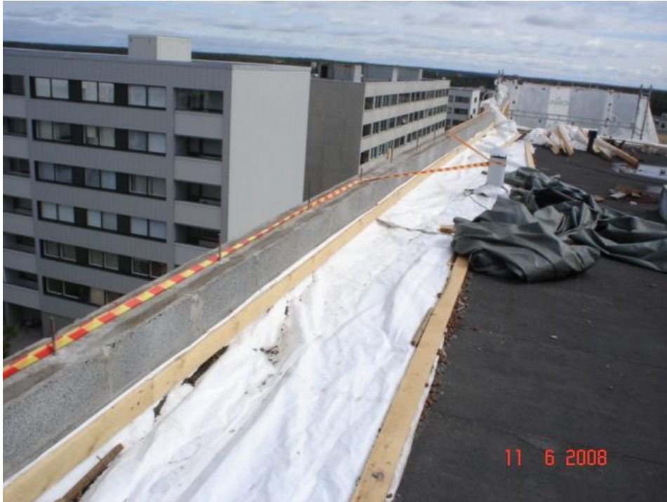
Kuva 7. Uusi leca-harkoista muurattu reuna.
