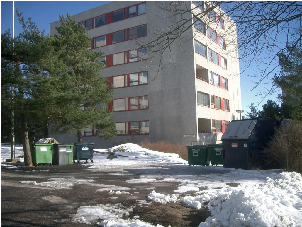
Kuva 1. Talo B ennen julkisivun purkua.
