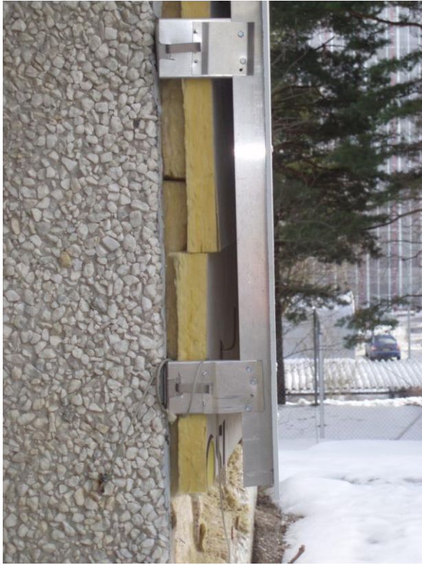
Kuva 4. Rakennuslevyn kiinnitys ja uusittu lämmöneriste.
