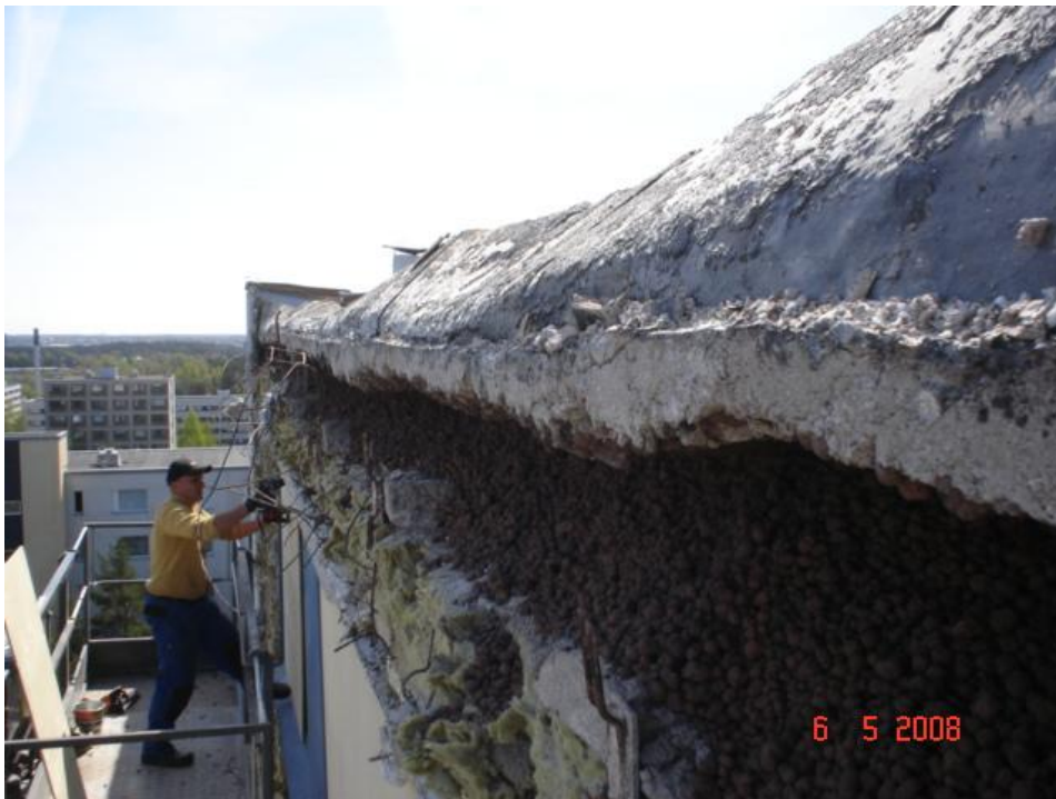
Kuva 6. Katon liittymän purku.
