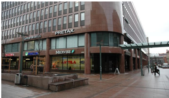
Kuva 4 Rakennusteknistä julkisivurakentamista Helsingin Kampissa
