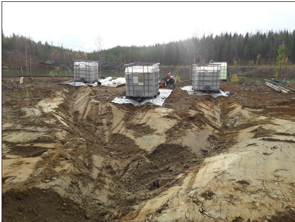
Kuva 17. Valmiit käsittelykontit ja vesien poistouoma (Leskinen 2019-10-31.)
