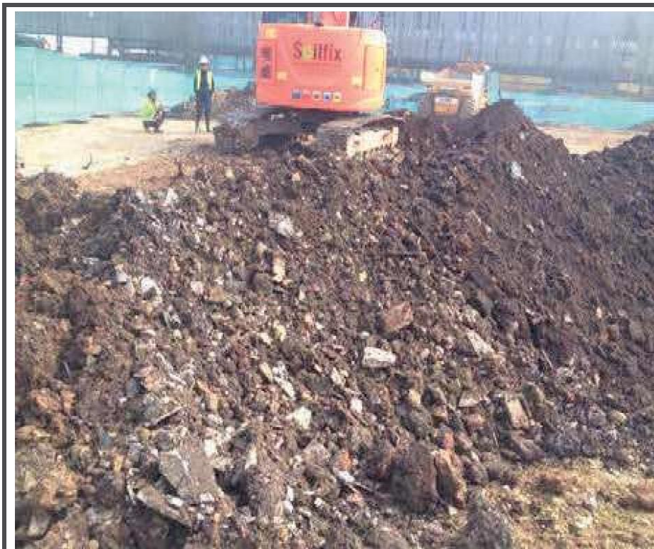
Kuva 9. Esimerkki rapautuneesta asbestisementtijätteestä ylöskaivetussa täyttömaassa. (Soilfix Limited).
