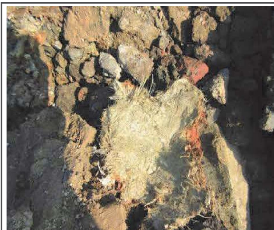
Kuva 23. Erittäin vahingoittunut/hajonnut asbestieristyslaatta ylöskaivetussa täyttömaassa. (Hydrock).
