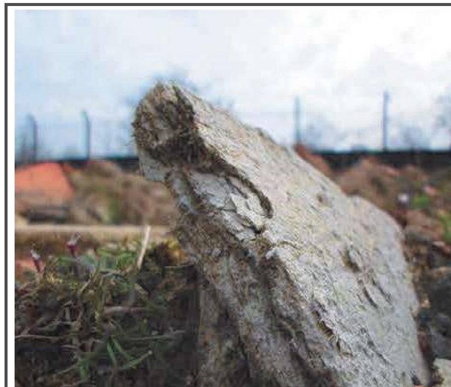
Kuva 22. Lähikuva vahingoittuneesta asbestieristyslaatasta täyttömaan pinnalla. (Hydrock).
