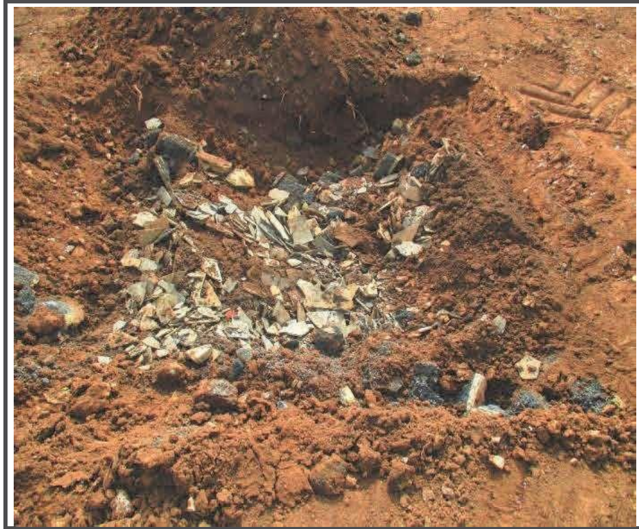
Kuva 2. Kuoppa, jossa vahingoittuneita asbestisementtikappaleita ja vapaita asbestikuituja. (VertaseFLI).
