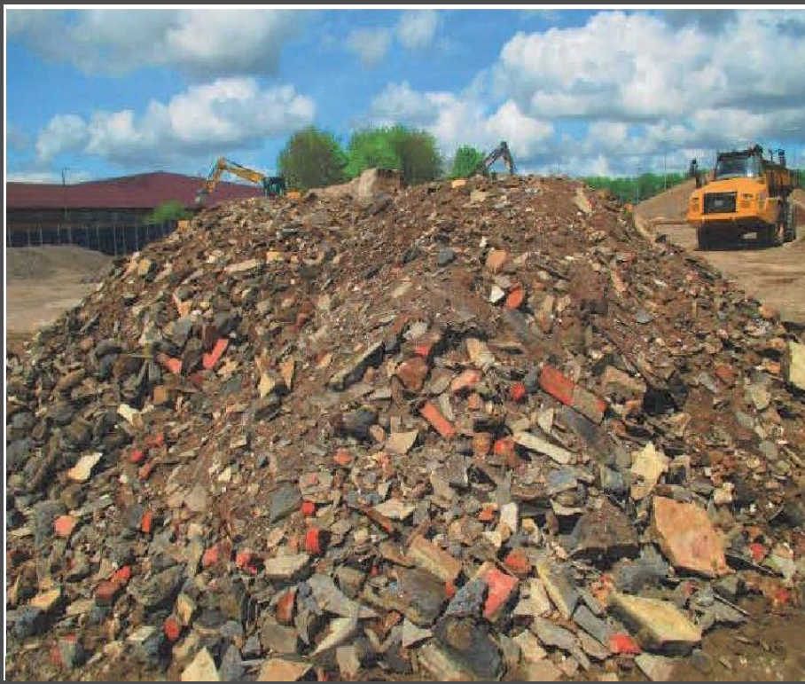
Kuva 1. Erinomainen esimerkki koskemattomasta ylöskaivetusta täyttömaan krysotiliasbestipitoisesta sementistä. (VertaseFLI).
