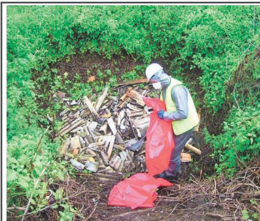
Kuva 5. Kuvassa kerätään halkeillutta, laittomasti hylättyä, mutta koskemattomia asbestisementin palasia sementtivuorausjätteestä. (VertaseFLI).
