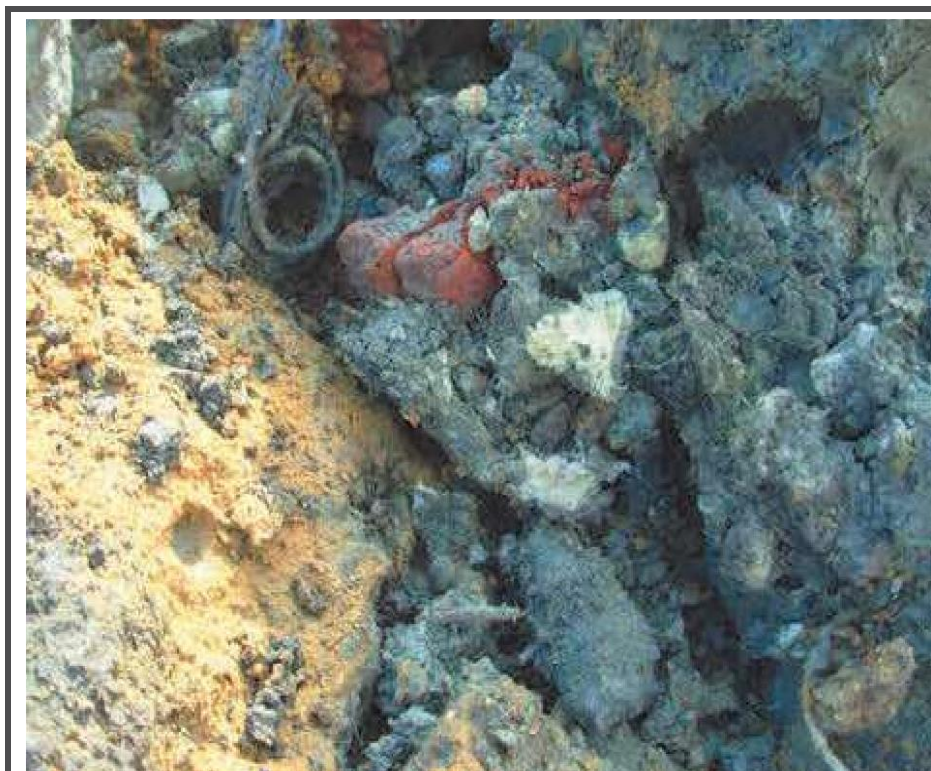
Kuva 29. Täyttömaan kontaminaatio, jossa asbestipitoista lämpöeristettä/kuitujätettä. (Soilfix Limited).
