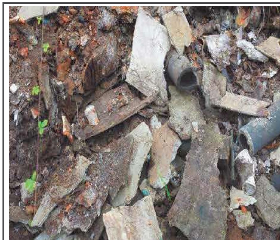
Kuva 20. Lähikuva vahingoittuneesta asbestieristyslaatasta täyttömaan pinnalla. (Hydrock).
