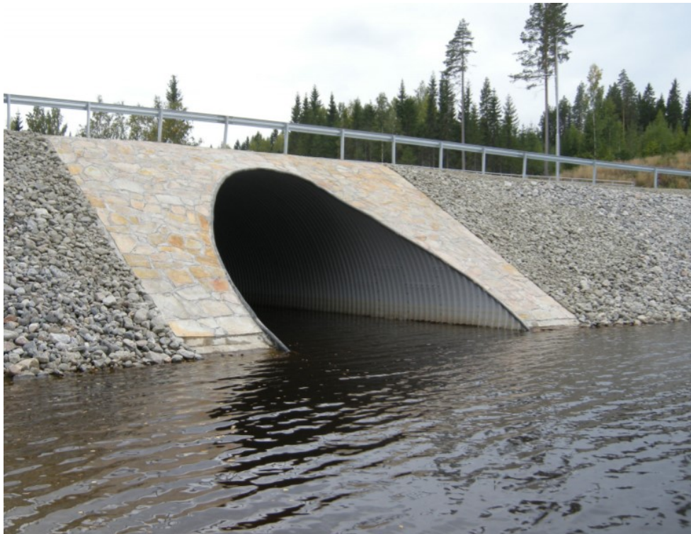
Kuva 8. Teräksinen putkisilta (Väylävirasto, 2012c, kansilehti)
