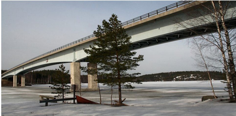
Kuva 9. Liittopalkkisilta (Väylävirasto, 2013b, s. 68)
