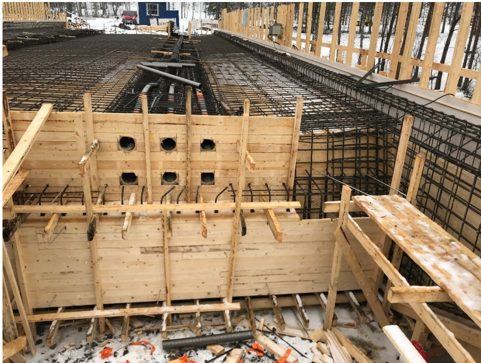
Kuva 17. Raudoitustyöt jatkuvat ja muottia osittain tuplattu
