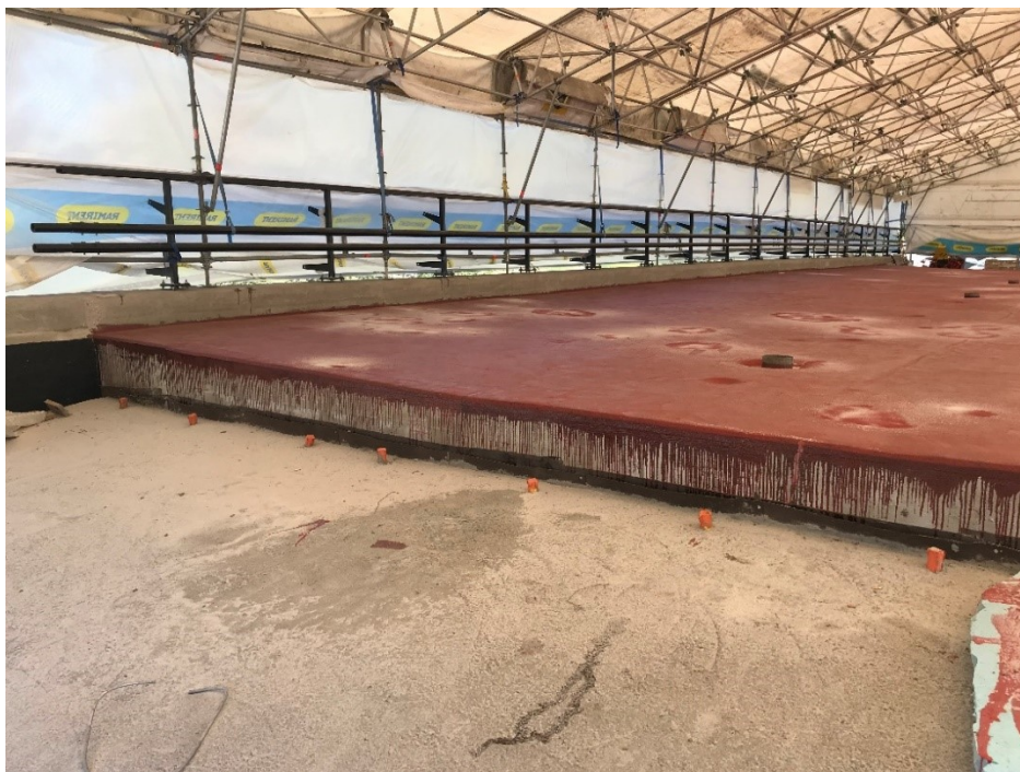
Kuva 23. Epoksitiivistys tehty
