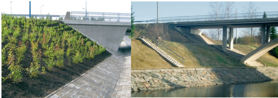
Kuva 27. Siltapaikan viimeistelyjä (Väylävirasto, 2015, kansilehti, s. 18)
