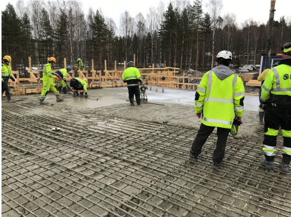
Kuva 18. Kannen betonointia
