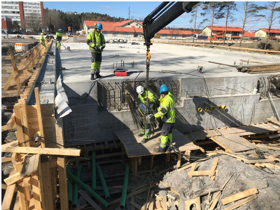
Kuva 20. Jännittämistyöt käynnissä ja taustalla vedeneristysalustan kunnostusta
