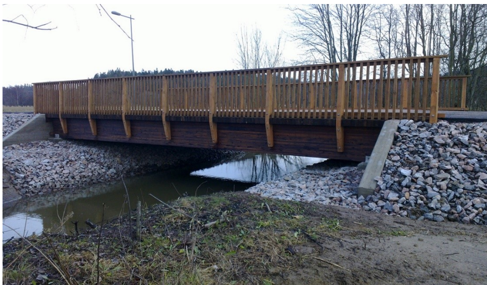
Kuva 10. Puinen palkkisilta (Versowood, 2017)
