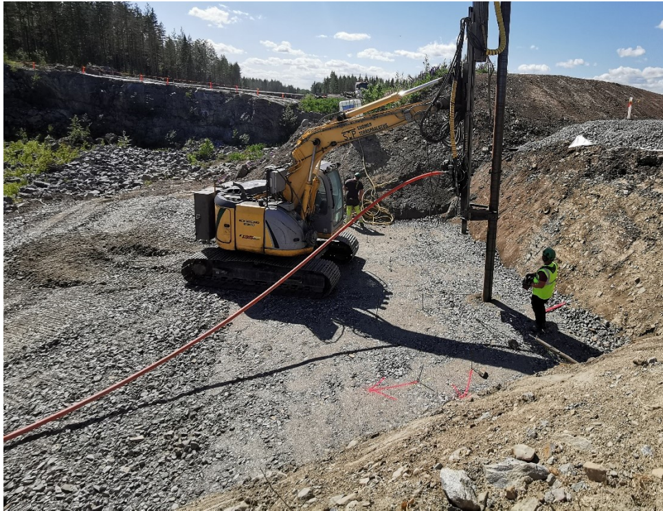
Kuva 13. Peruslaatan paalutustyöt käynnissä
