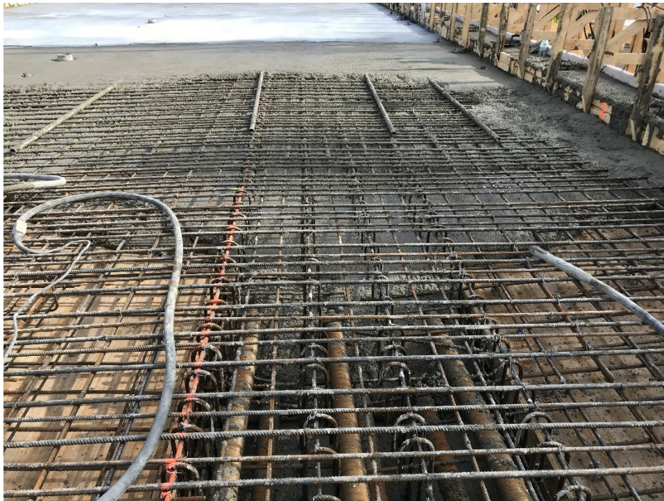
Kuva 19. Kannen betonointi etenee
