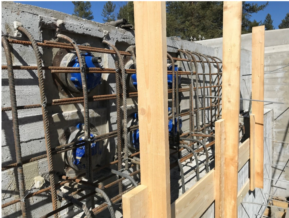
Kuva 21. Jännittämistyöt ja injektioinnit tehty
