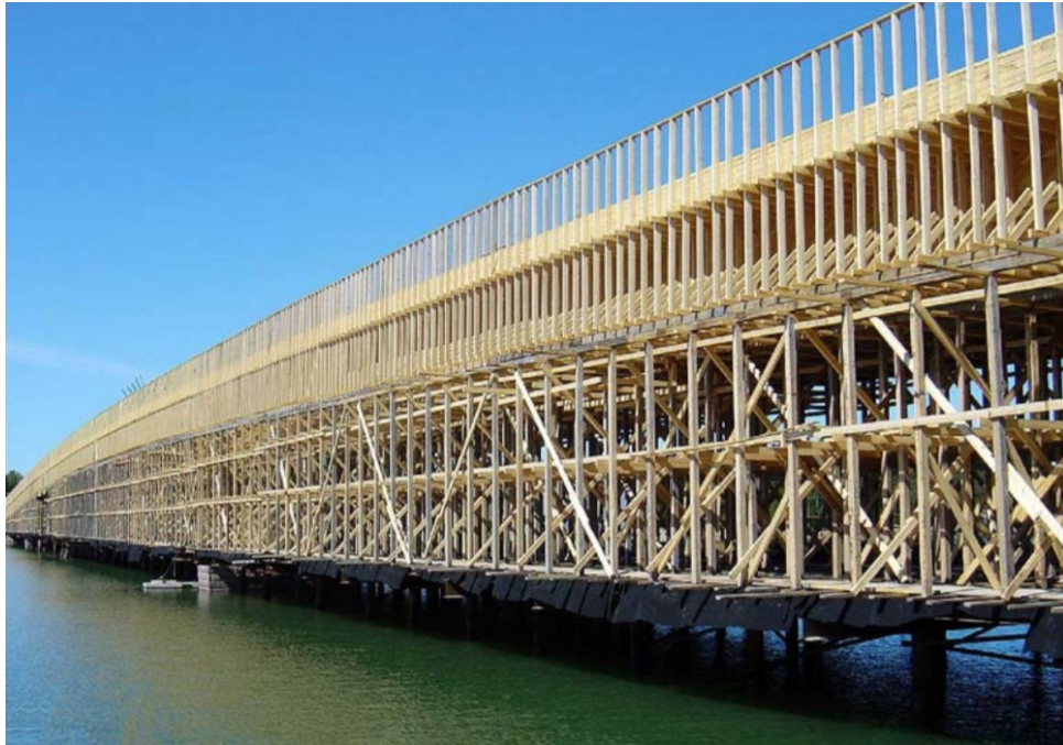
Kuva 15. Sillan tukitelineet (Väylävirasto, 2007, s. 16)
