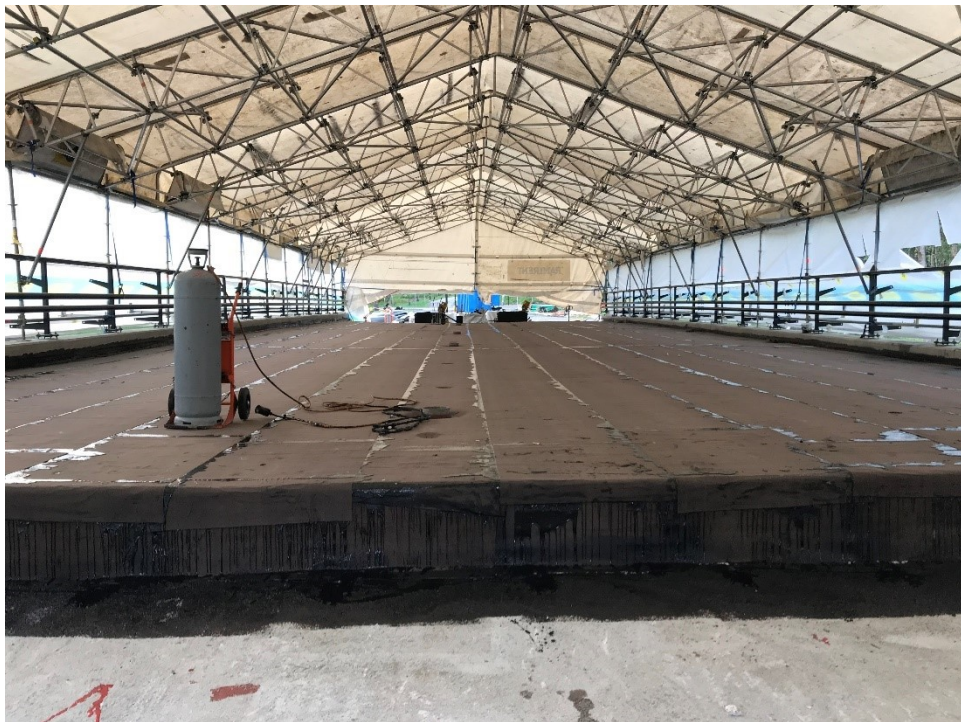
Kuva 24. Aluskermi asennettu
