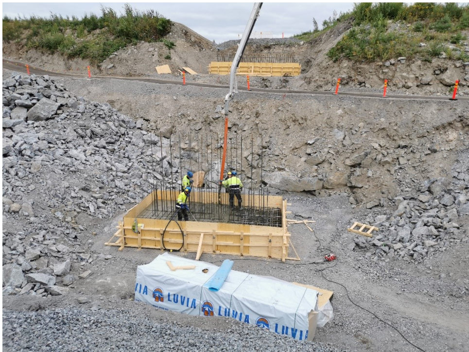
Kuva 14. Peruslaatan betonointia
