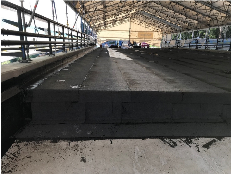
Kuva 25. Pintakermi asennettu
