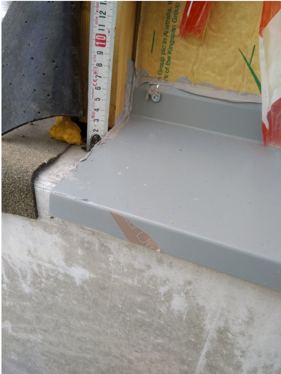
Kuva 2. Viistosateen torjumiseksi asennettu väliaikainen tippapelti, sekä ikkunapenkin huopa, jotta vesi ei pääse eristetilaan. (Tuunainen, 15.6.2018)
