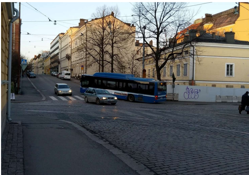
Kuva 26. Suojatiemaalauksen näkyvyys on huomattavasti heikompi mu- kulakivisellä ajoradalla.
