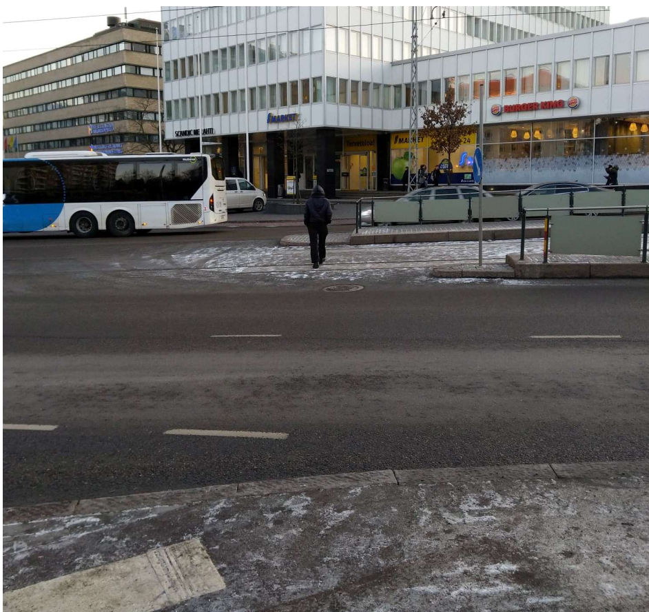
Kuva 23. Suojatietön kadunylityspaikan toteuttaminen vaatii reunakivien madallusta ja pysäkin kaiteen sekä päädyn rakenteiden muokkausta.
