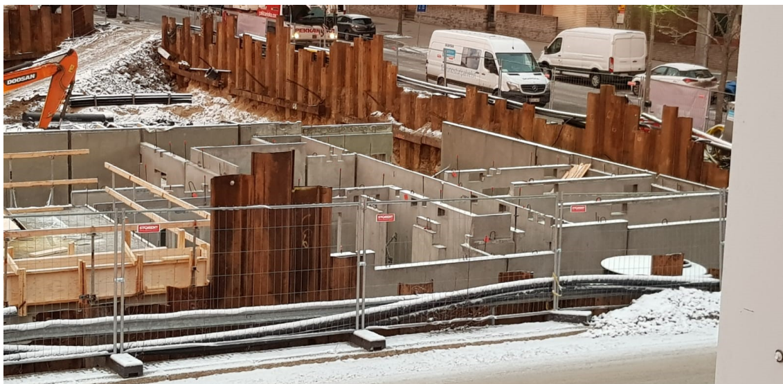
Kuva 11. Sokkelielementit asennettu
