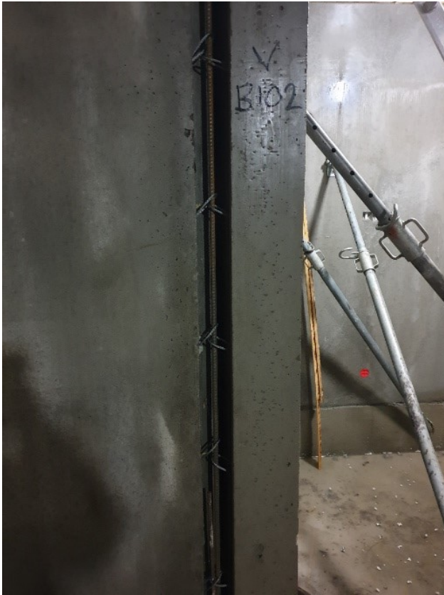
Kuva 12. Raudoitettu pystysauma
