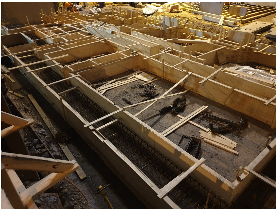
Kuva 9. Tilanne ennen raudoitustarkastusta.
