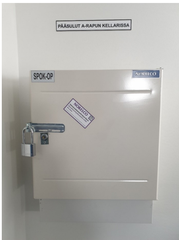
Kuva 22. Lukitus vaihdettu riippulukkoon.
