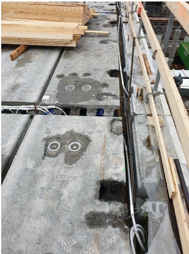
Kuva 13. Raudoitettu ontelokenttä
