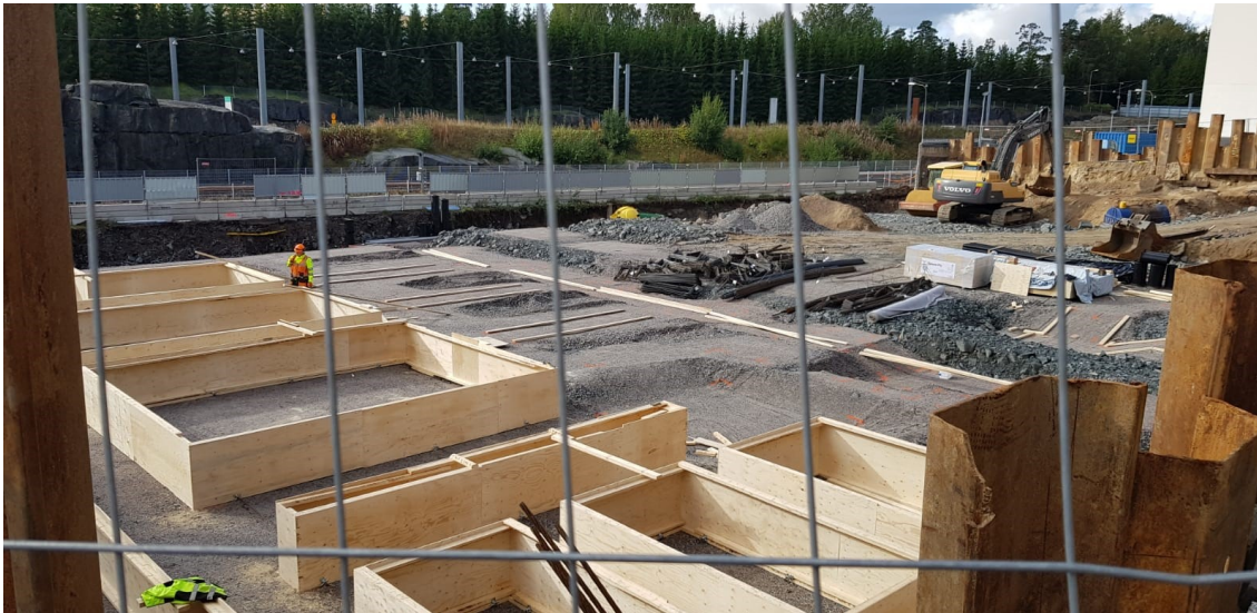
Kuva 8. Perustusten pohjatyöt tehty, muottejakin aloitettu
