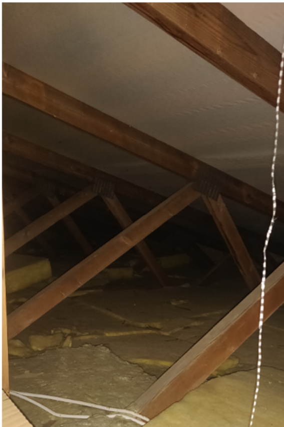
Kuva 8. Toimistotilan yläpohjan lämmöneriste
