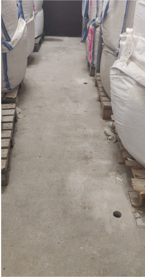
Kuva 7. Betonilattiaan porattuja tarkastusreikiä
