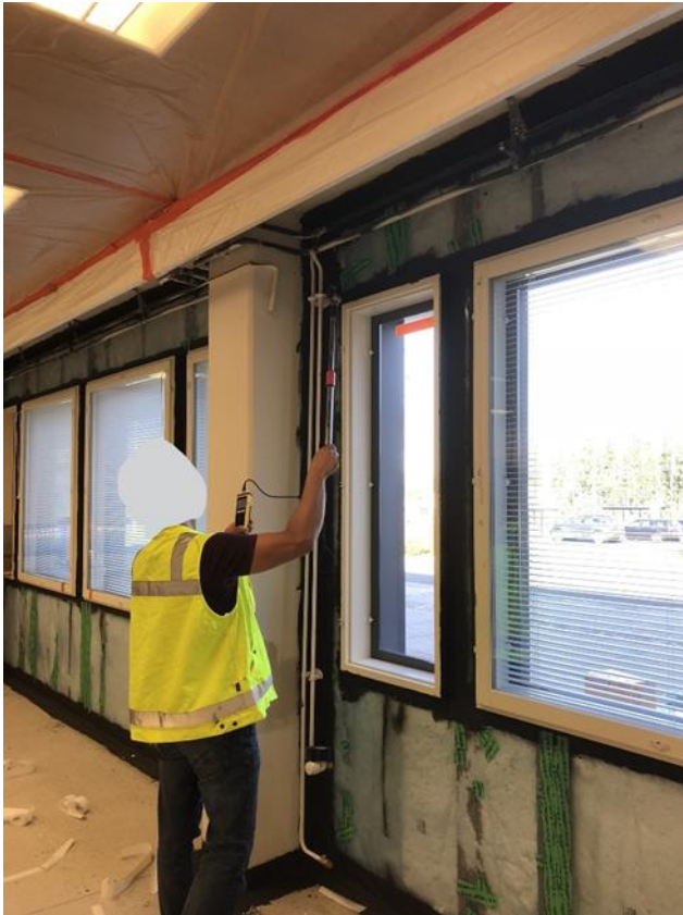
KUVA 11. Tiiveyden mittaus Trotec-mittalaitteistolla.
