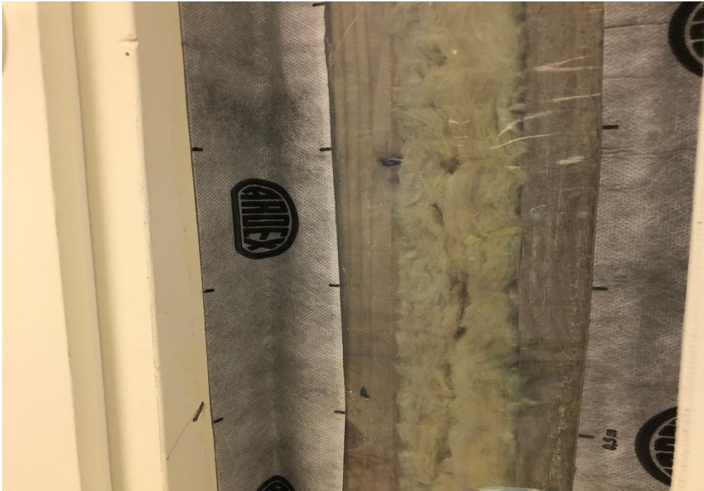
KUVA 10. Ikkunakarmin ja höyrynsulkumuovin liittymän tiivistys Ardex STB 75 -tiivistysnauhalla.
