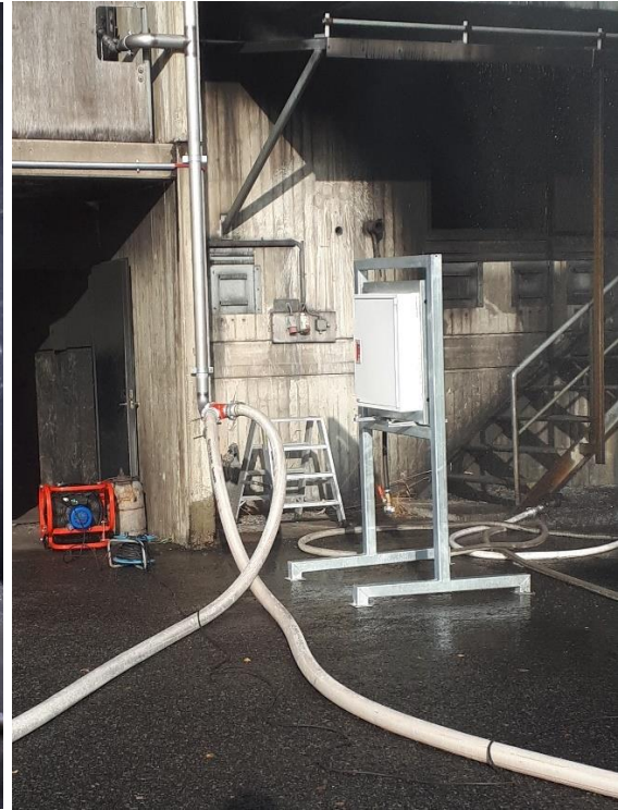
Kuva 7. Veden syöttö kuivanousujohtoon.
