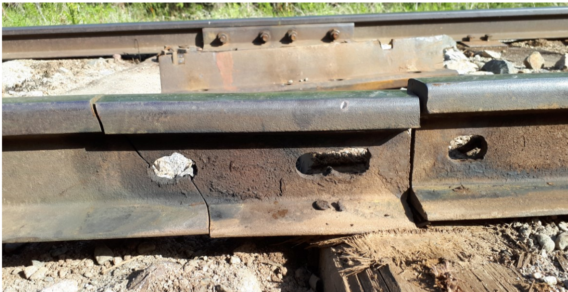
KUVA 6 Väärin porattujen kiinnitysreikien aiheuttama kiskon katkeaminen
