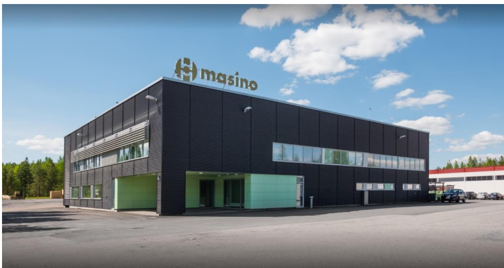
Kuva 1. Masino Industryn Ylöjärvellä sijaitsevat toimisto- ja tuotantotilat (Masino industry yleisesite 2018)
