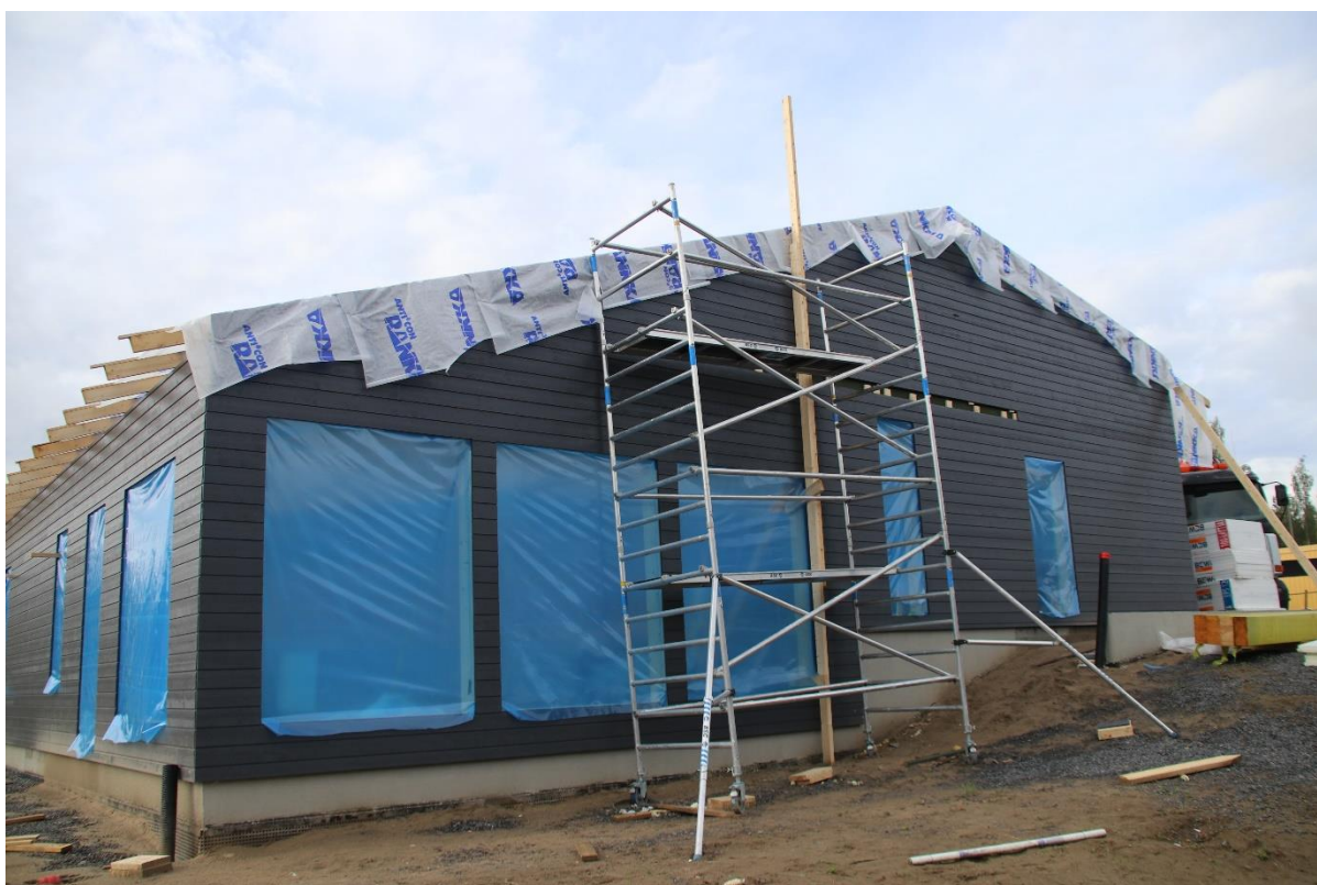
Kuva 1. Asiakkaan talon rakennustyömaa (kuva: Roosa Pirinen).
