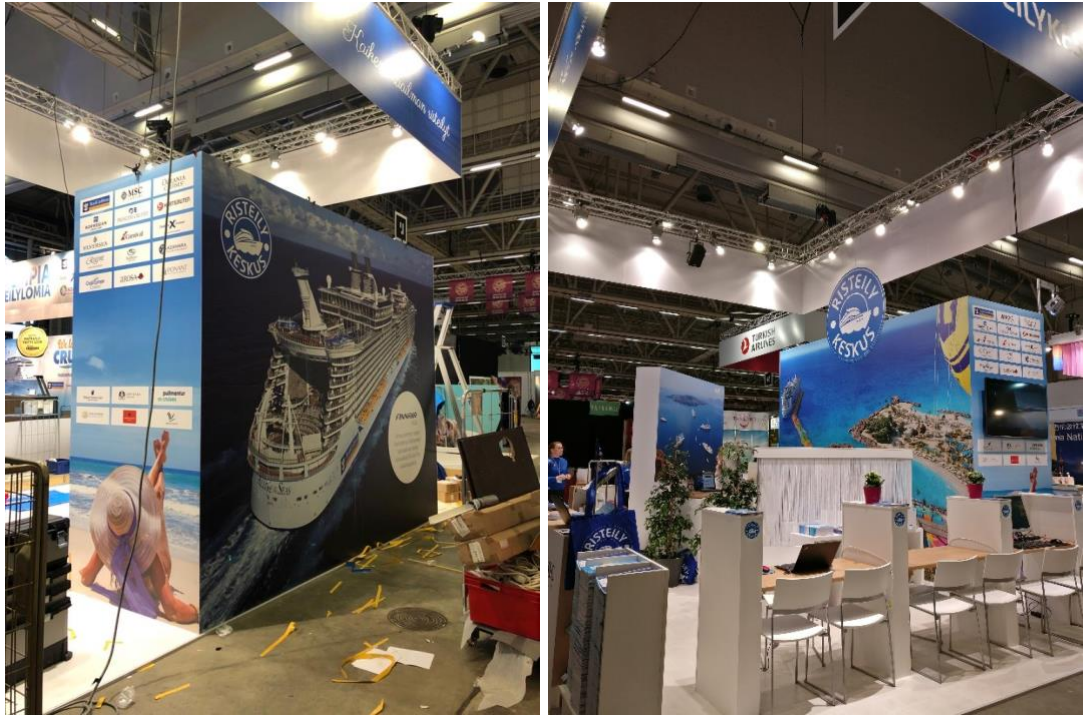
Kuvat 2 (vasen) ja 3 (oikea). Risteilykeskuksen messuosaston takaseinä rakennusvaiheessa sekä messuosaston asiakaspalvelutiskit
