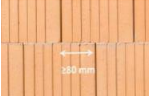
Kuva 9. Harkkojen limitys (Wienerberger 2019a)
