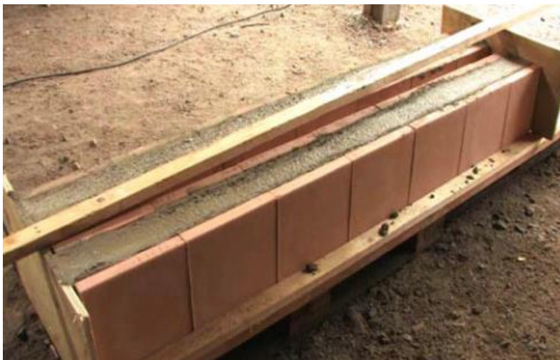
Kuva 11. U-harkkopalkkien tuenta valun ajaksi (Wienerberger 2019a)
