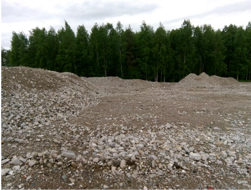
Kuva 10. Valmista rakennekerroksen pintaa, johon käytettiin purkukohteen poistettuja betoneja (Kati Anttila 2019).
