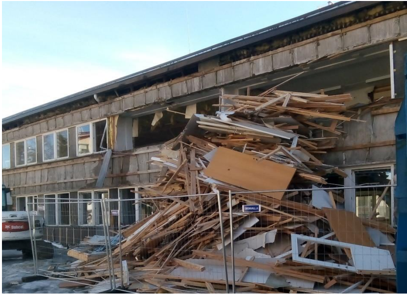
Kuva 1. Puisten rakennusosien purkutyö ja kerääminen yhteen (Kati Anttila 2019).
