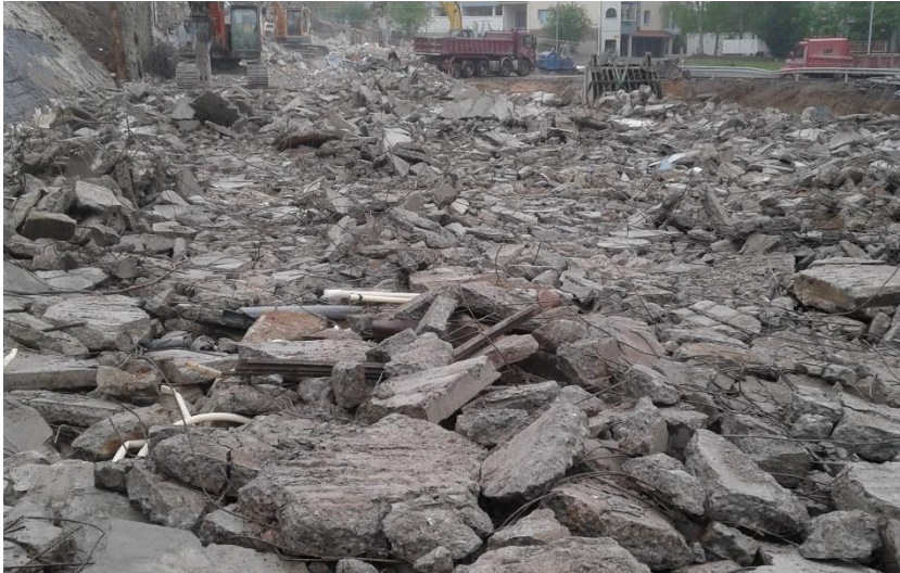
Kuva 8. Kohteen betoninen lattialaatta rammeroinnin jälkeen (Kati Anttila 2019).
