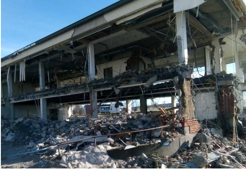
Kuva 3. Kantavien pilarien väliset seinäosat poistettiin ennen pilarien purkua (Kati Anttila 2019).
