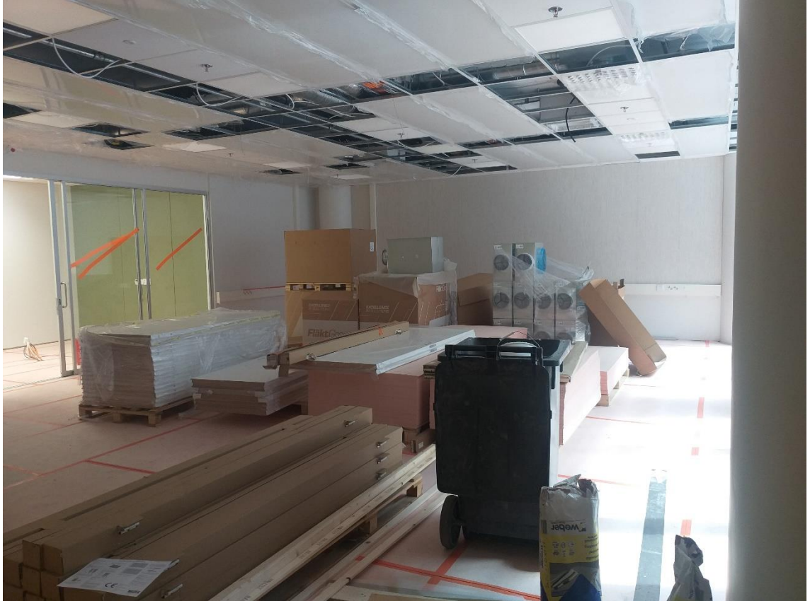
Kuva 10. Työmaan sisätiloissa tapahtuva työaikainen varastointi. Kuva Severi Suominen 2019
