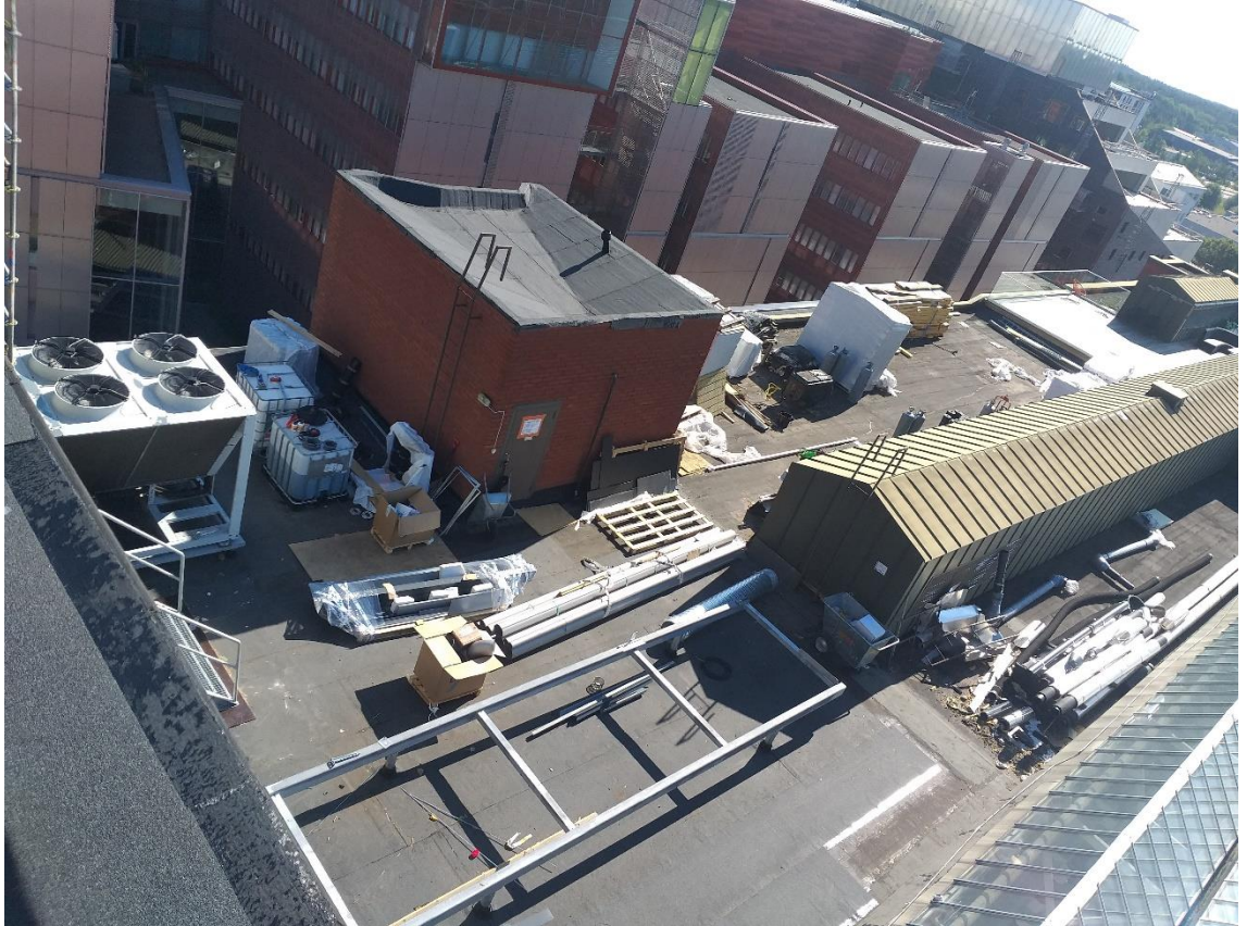
Kuva 11. Kiinteistön vesikatto. Kuvattuna IVKH:neen vesikatolta. Kuva Severi Suominen 2019.
