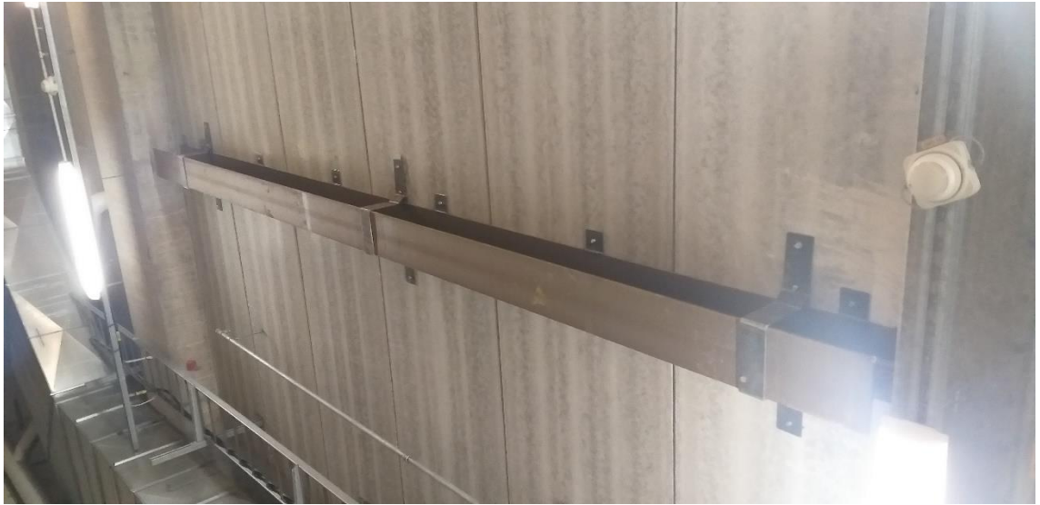
Kuva 8. Holvin alapintaan asennettu H-palkki. Kuva Severi Suominen 2019
