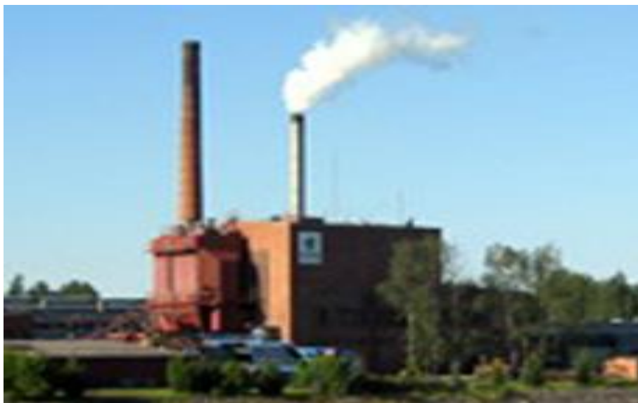
Kuva 1. Vaneritehtaan voimalaitos (upm.com)
