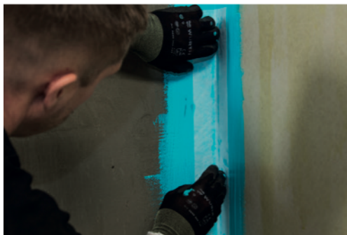
Kuva 18. Vedeneristeen nurkan vahvikenauhan asennus (Kiilto 2019).
