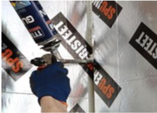
Kuva 15. SPU-levyn nurkan vaahdotus (Kingspan 2019b).
