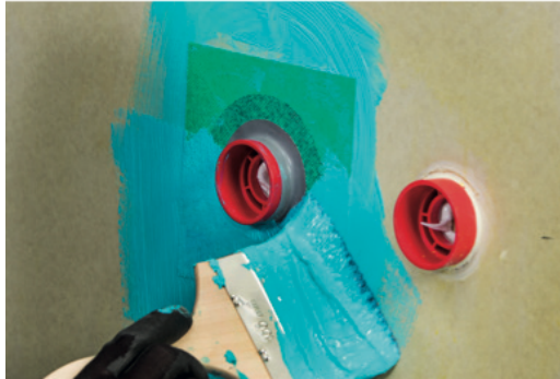
Kuva 19. Läpiviennin tiivistäminen vahvikelapulla (Kiilto 2019).
