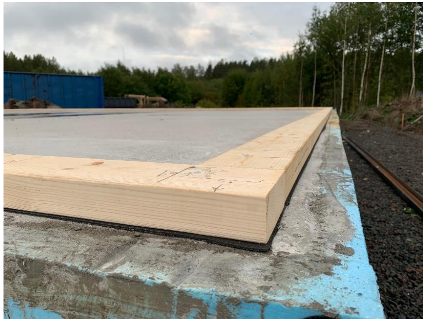
Kuva 5. Alaohjauspuun eristäminen bitumikaistaleella.
