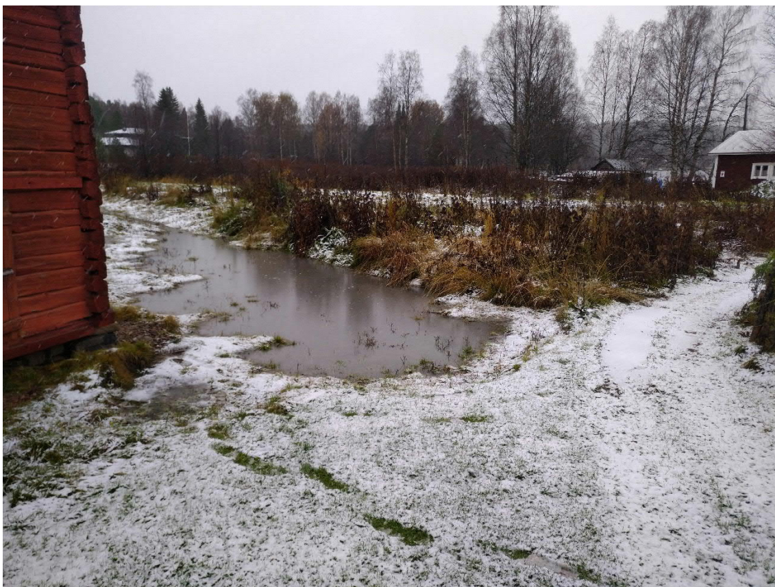
Kuvio 4. Johtojen päällä oleva maakerros sekä ojien muotoilu aiheuttavat vesipesän
