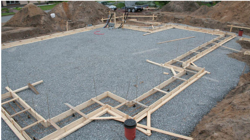
Kuva 12. Anturoiden tekeminen laudoista (Rakentaja.fi 2007 b)
