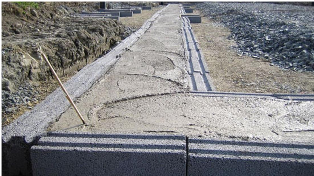
Kuva 13. Anturoiden tekeminen harkoista (Rakentaja.fi 2007 a)
