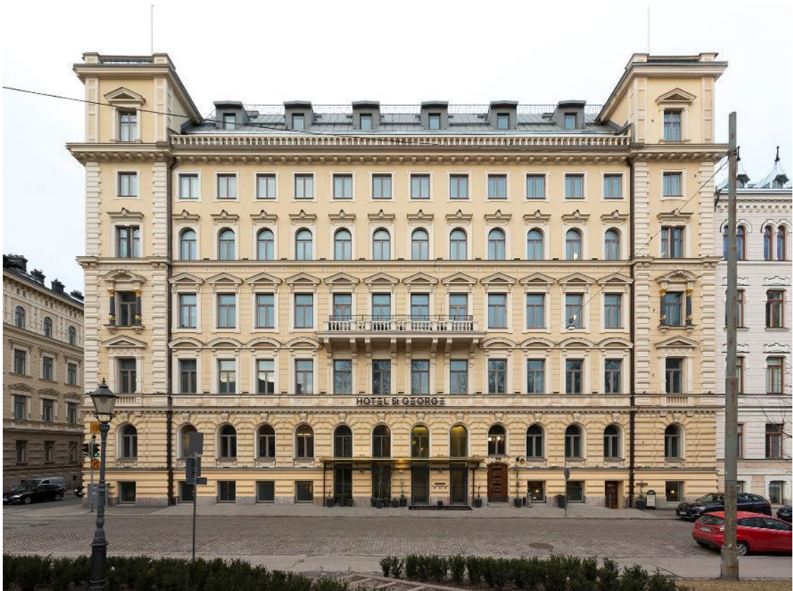
Kuva 5. St.George -hotellin pääsisäänkäynnin julkisivu [kuva arkkitehtitoimisto Arkval Taite Architects, tekijän luvalla].
