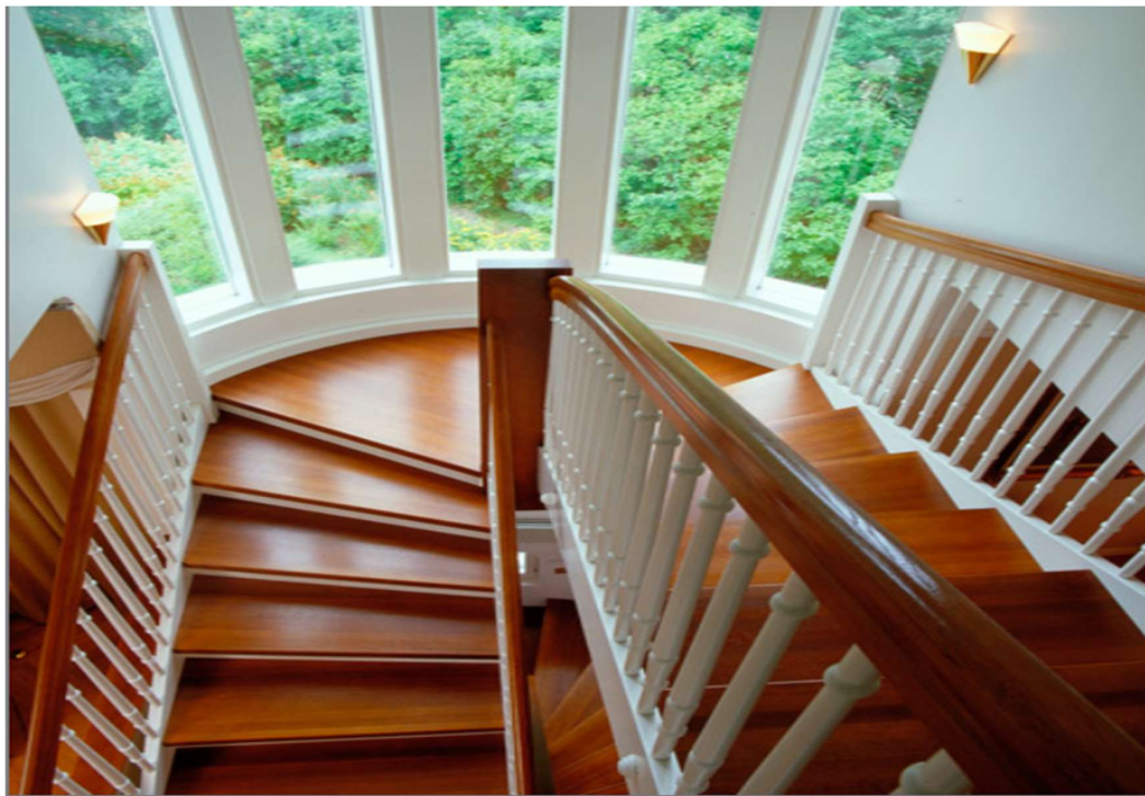
Kuva 25. Vakiomallinen D-s2, d2 pintaluokan puuporras. Normaali lakka- tai maalikäsittely ei vai- kuta pintaluokitukseen. [Hovinikkarit Oy:n verkkosivut]
