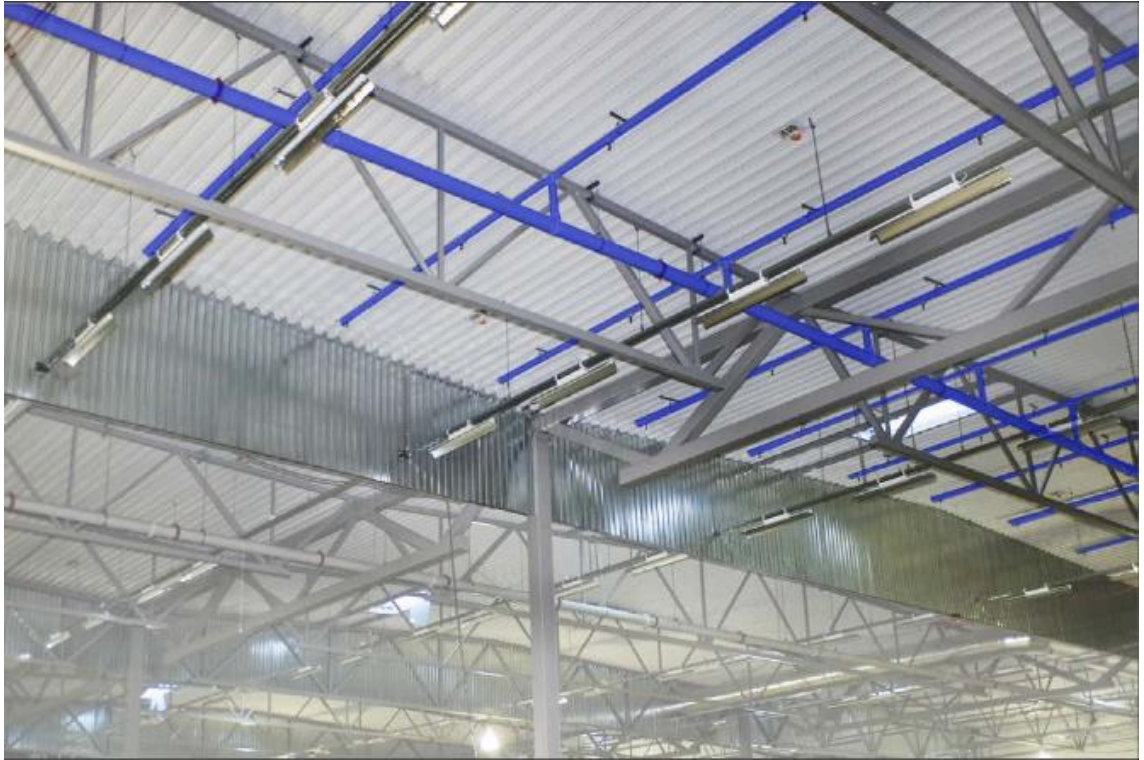
Kuva 2. Teräsrakenteiden suojaus sprinklerilaitteistolla (Outinen 2013, 22)
