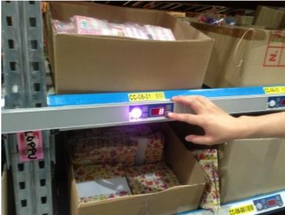
Kuva 7. Valo-ohjaus. (Fimatic Oy 2020)
