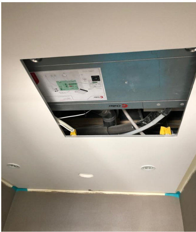
Kuva 3. Chillerin Grand-puhallinkonvektori
