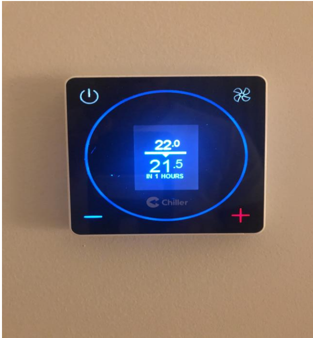
Kuva 4. Varipro-huonesäädin
