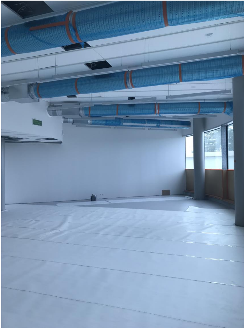
Kuva 16. Valmiit ilmastointiasennukset suojattuna.
