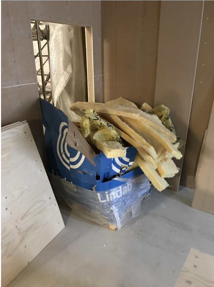
Kuva 14. Villa laitettu ilmastointilaatikoiden päälle.
