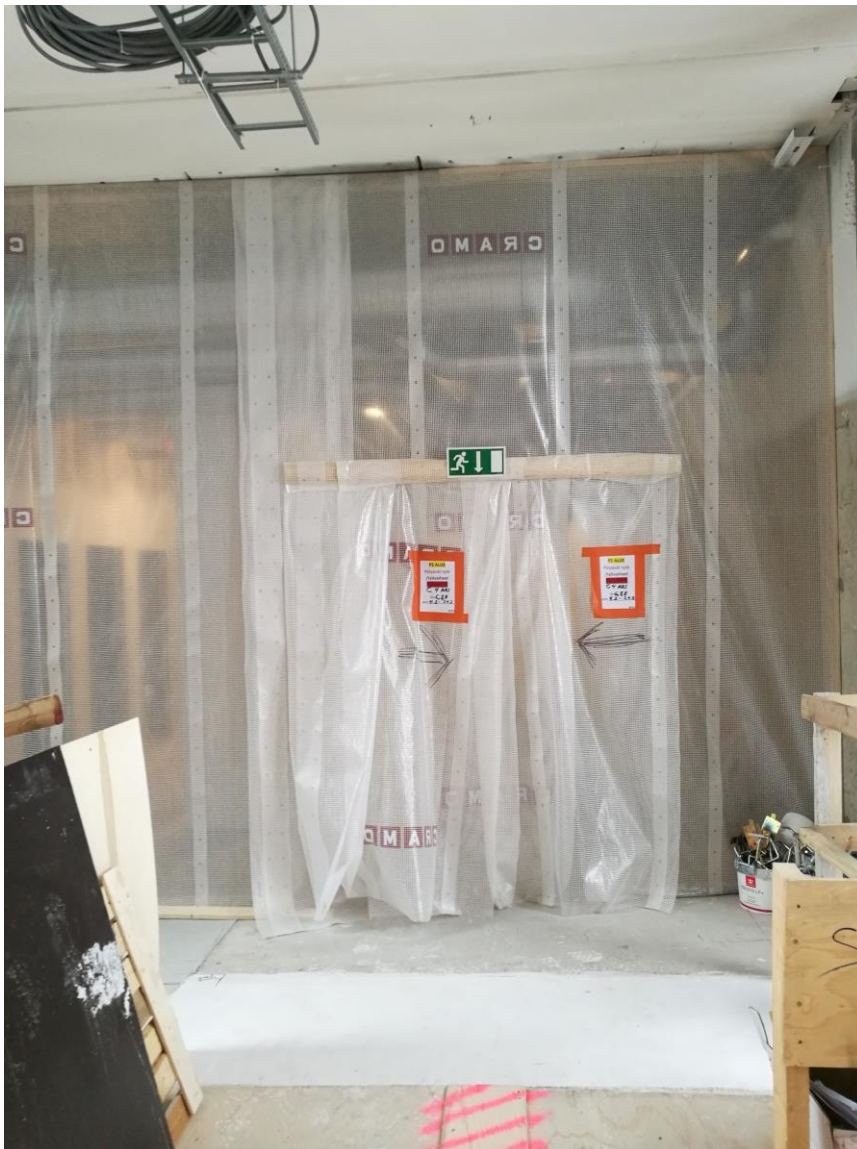
Kuva 6. Kulkuovi rakennettu muovista.
