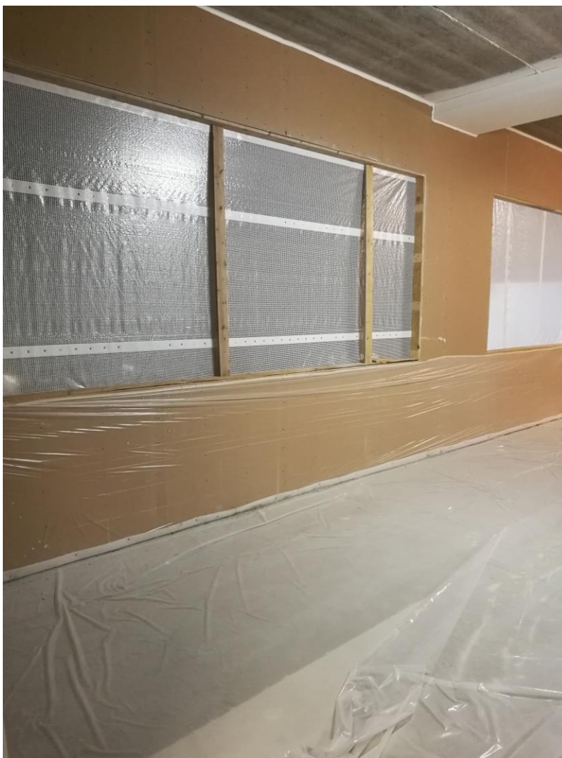
Kuva 7. Ikkuna-aukot suojattu suojamuovilla.
