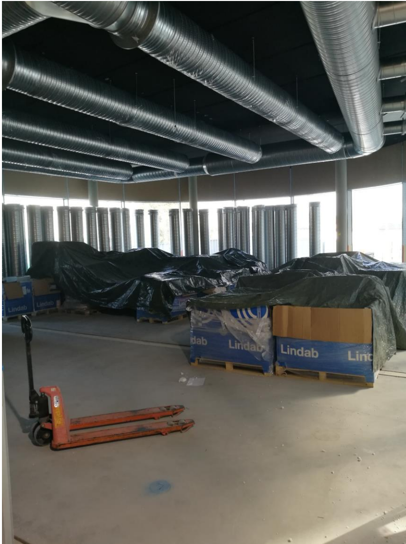
Kuva 13. Työmaalla varastoidut ilmastointikanavat ja osat.
