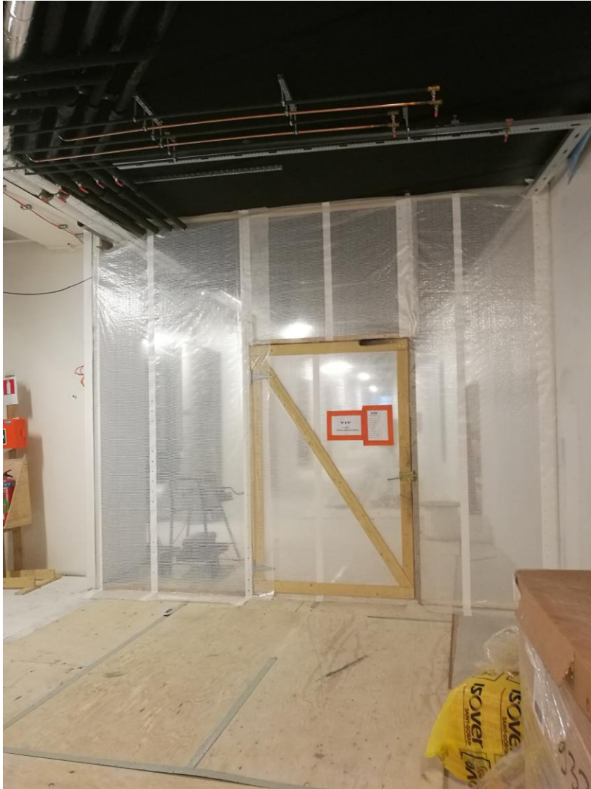
Kuva 5. Työmaalla oleva suojaseinä ja kulkuovi.
