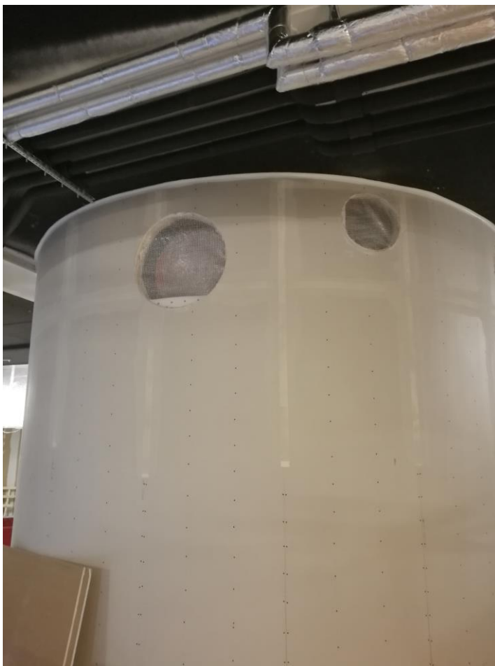
Kuva 8. Ilmastointikuilun läpivientireiät suojattu muovilla.
