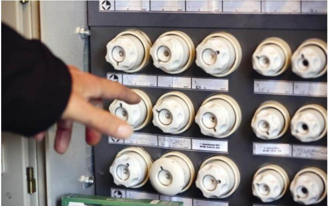
Kuva 2. Oikein toteutettu sormisuojaus [4]
