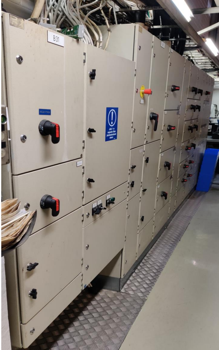
Kuva 7. Tarkastetut sähkökeskukset B31 ja A31
