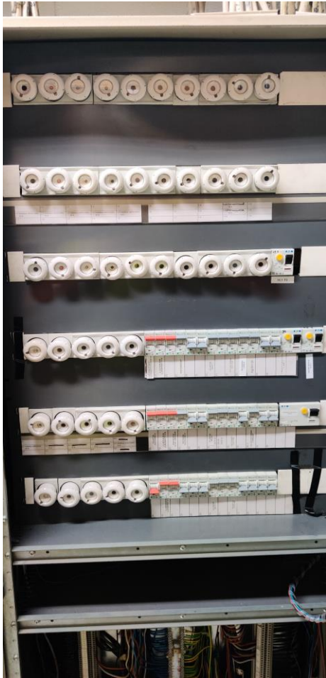
Kuva 10. Teipillä kiinnitetyt sormisuojat
