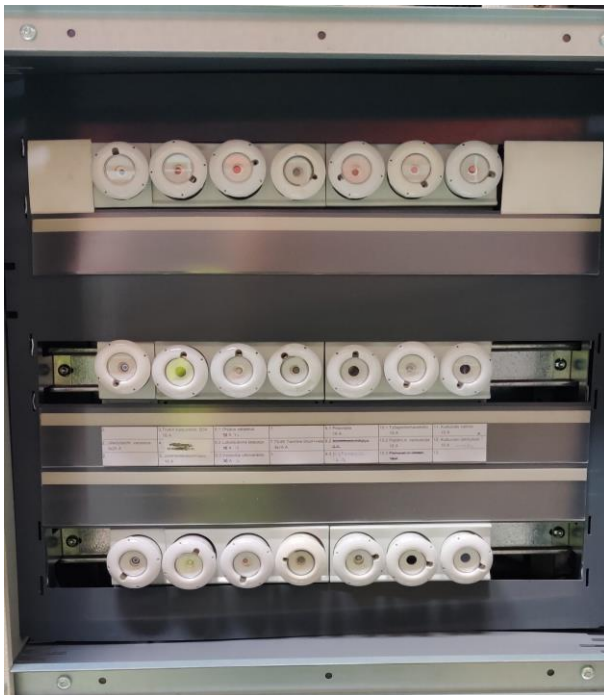
Kuva 11. Puuttuvat sormisuojat
