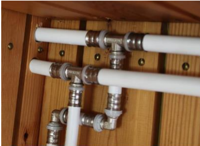
Kuva 1. Komposiittiasennus ilman suojakuorta
