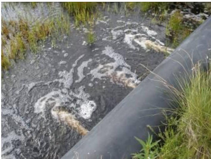
Kuva 6. Veden jakamiseen käytetään usein reikäputkea. Kuva Ristinevalta (Majalahti 2011)
