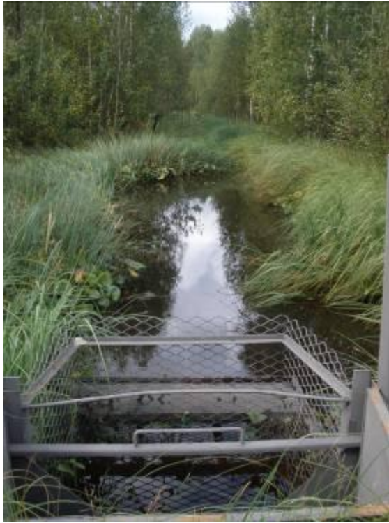
Kuva 7. Vesi poistuu pintavalutuskentän alueelta yleensä patorakenteen kautta. Kuva Iso-Hakonevan yläpuolisen veden tarkkailupisteeltä. (Majalahti 2011)
