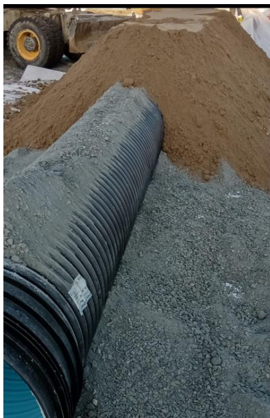
KUVA 1. Hulevesiputki murskearinalla ja hiekkatäytöllä
